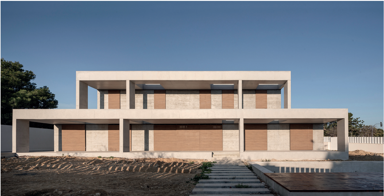
Figure 9. Concrete and its textures. 2020. ©David Zarzoso / Figura 9. El hormigón y sus texturas. 2020. ©David Zarzoso.
