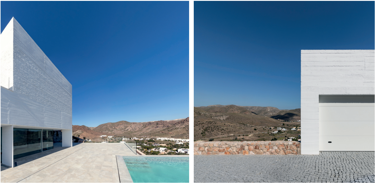
Figure 5. Solarium. Detail of the corner column and detail of the wall of garage. Estudio JFGS. 2016-2018. ©A.L. Martínez-Cano / Figura 5. Vista de la plataforma de la piscina. Detalle del pilar de hormigón de la esquina y Vista del alzado posterior. Detalle del muro exterior de la cochera. Estudio JFGS. 2016-2018. ©A.L. Martínez-Cano.
