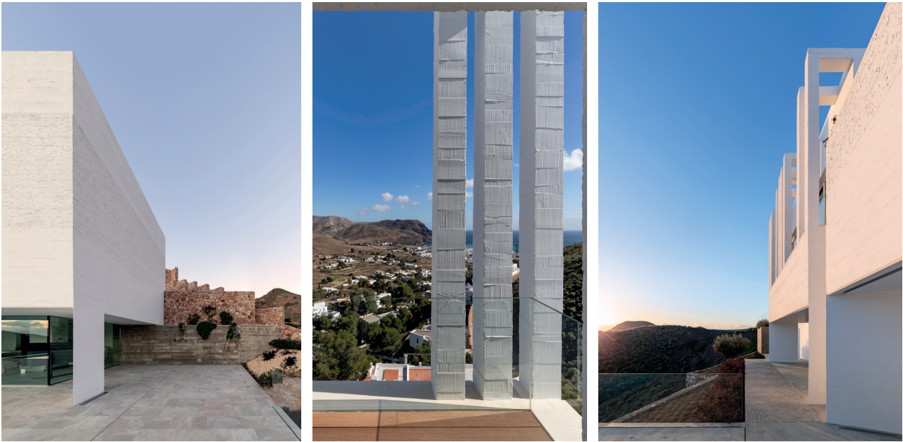
Figure 4. Detail of the beams and vertical elements, detail of the latticework of vertical elements in the bedrooms and view of the kitchen porch. 2016-2018. Estudio JFGS. ©A.L. Martínez-Cano / Figura 4. Detalle de las vigas y elementos verticales, detalle de la celosía de elementos verticales de la zona de los dormitorios y vista del porche de la cocina. 2016-2018. Estudio JFGS. ©A.L. Martínez-Cano.
