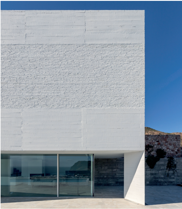
Figure 1. Concrete textures, principal elevation and back elevation. Estudio JFGS. 2016-2018. ©A.L. Martínez-Cano / Figura 1. Texturas de hormigón. Alzado principal y alzado posterior. Estudio JFGS. 2016-2018. ©A.L. Martínez-Cano.
