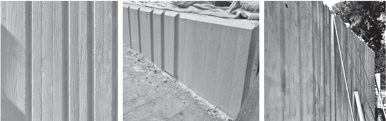
Figure 10. Texture of the concrete on the wall in casa de la Roca. 2019. ©Antonio Altarriba / Figura 10. Textura del hormigón en el muro en la casa de la Roca, Casa de la Roca. 2019. ©Antonio Altarriba.
