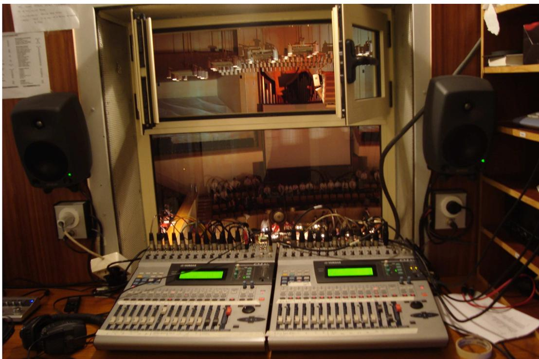
El sistema de micrófonos estaba gestionado por los técnicos del Palau, sin embargo, hubo que colocar algunos micrófonos adicionales para cantores y músicos solistas. En la imagen superior puede verse una de las cabinas de control de sala.
