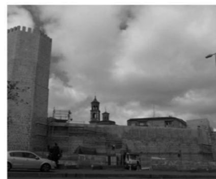
Trabajos de retirada de los andamios que cubrían la muralla en la ronda Dámaso Torán durante la mañana de ayer, que han dejado a la vista la restauración.
