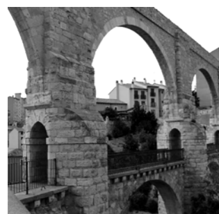
C ACUEDUCTO "LOS ARCOS"
