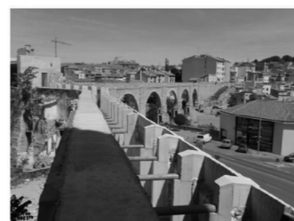
Vista del tramo parcialmente rehabilitado de la muralla desde la torre de la Bombardera, con el torreón del Agua a la izquierda
