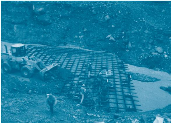
Figura 11. Protección de lecho con reja de acero estructural
