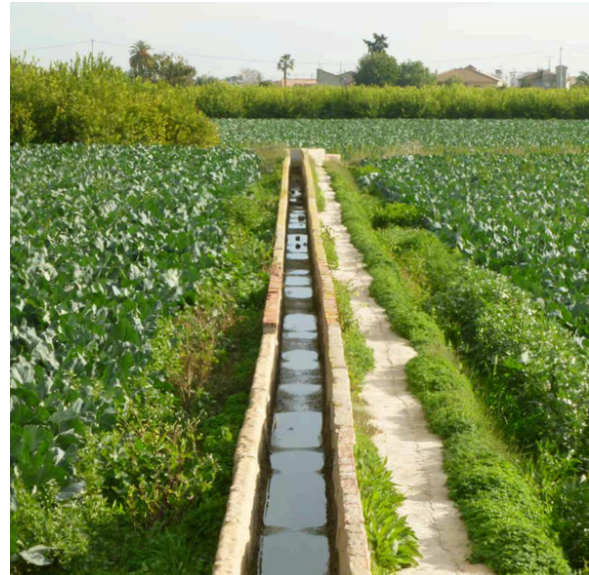
Detalle de las canalizaciones encargadas de transportar el agua hasta las parcelas de cultivo, Fuente: Libro "Orihuela, una ciudad rodeada de jardines"
