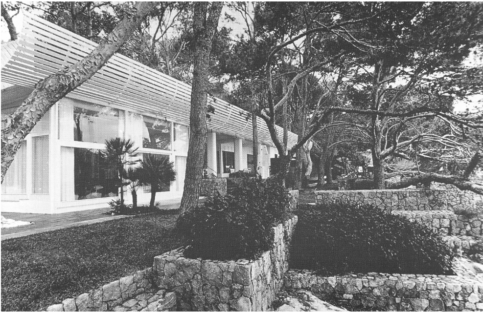
61. Vista de la casa desde el terreno abanclado.
