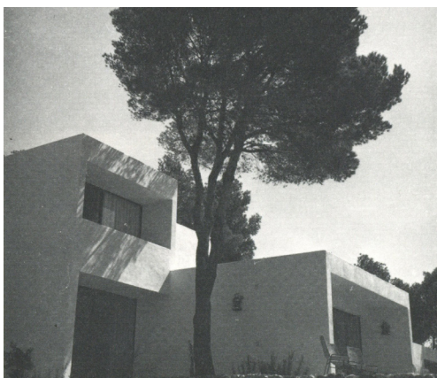
34. Vista exterior. Casa La Pionera.
