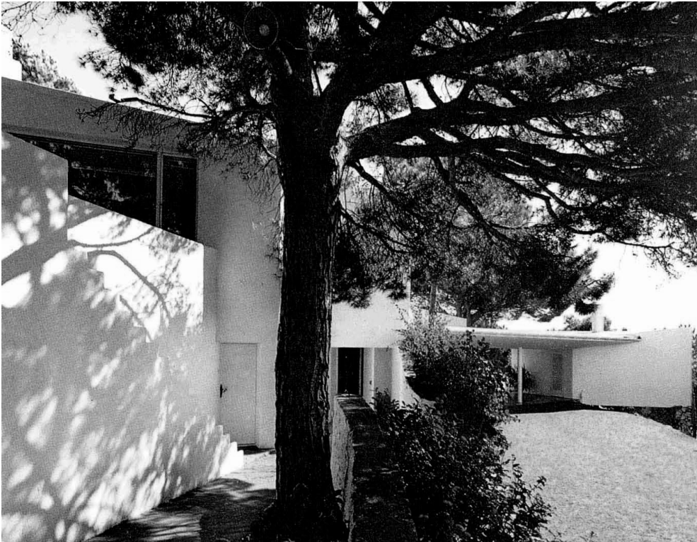
19. Vista del acceso.
