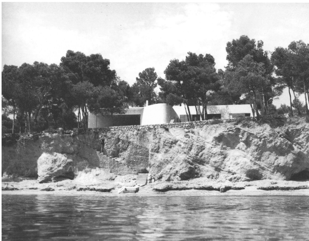
29. Fotografía de la Casa Fisac desde el mar.
