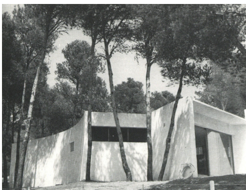
35. Vista exterior. Casa Fisac.
