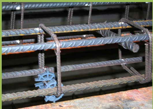
Colocación de separadores
