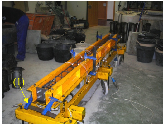
Figura 4.14. Armadura en el encofrado auto-vibrante preparado para el hormigonado.
