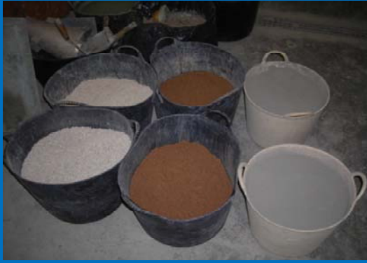
Preparación de los materiales
