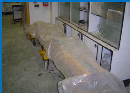
Soporte recién hormigonado (curado)
