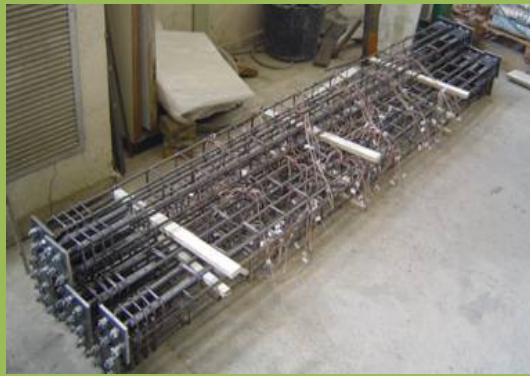
Preparación de la armadura
