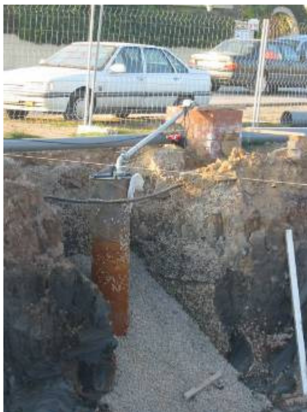
Figura 3.4.- Imagen de sumidero ( sump ) completamente equipado, tras la ejecución de la excavación (cortesía de FERRER, S.L.).
