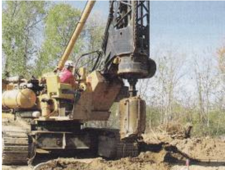
Figura 3.20.- Perforación con balde. (Powers et al. 2007).
