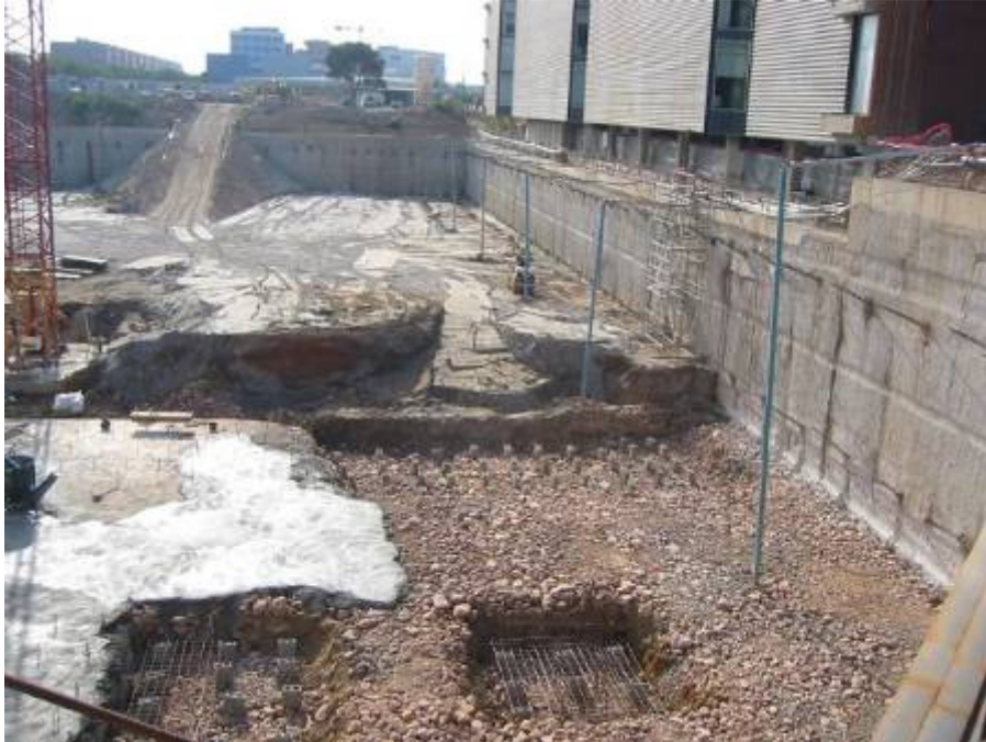
Figura 3.24.- Red de control con pozos de baja capacidad–Universidad Politécnica de Valencia– (Cortesía de FERRER, S.L.).
