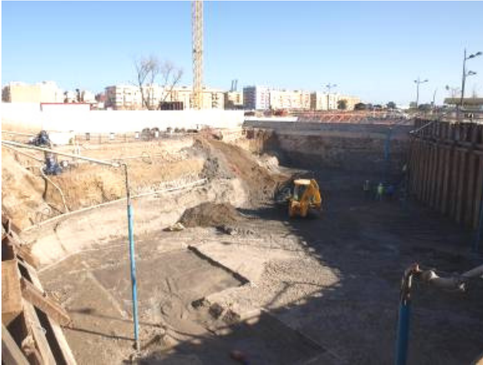
Figura 3.28.- Control de nivel freático con sistema combinado, wellpoint doble estadio y pozos profundos.(Cortesía de FERRER, S.L.).
