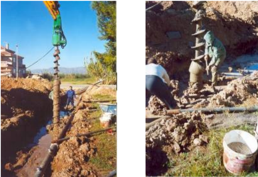
Figura 3.14.- Montaje de un filtro wellpoint. Izda. Asta helicoidal perforando con cabezal hidráulico. Dcha. Detalle del asta con extracción de lodo arcilloso. (Cortesía de FERRER, S.L.)
