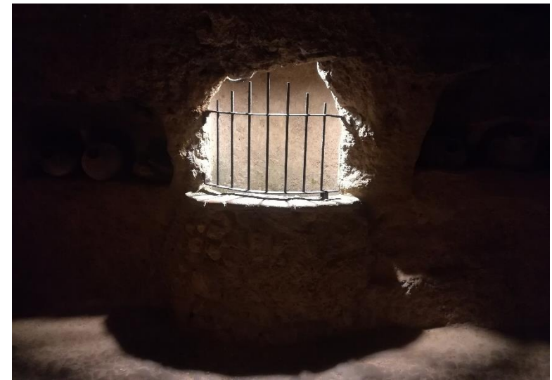
Figura 25. Iluminación en el pozo
