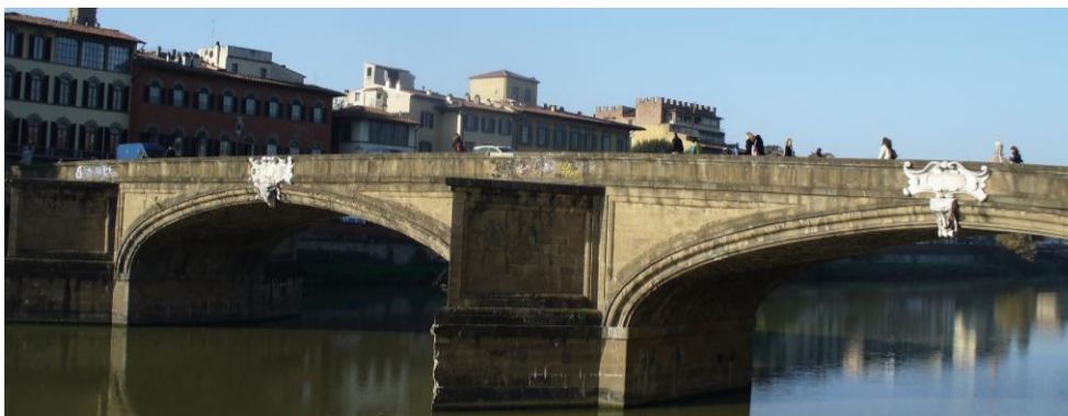
Figura 54. Puente de Santa Trinità tras la reconstrucción.
