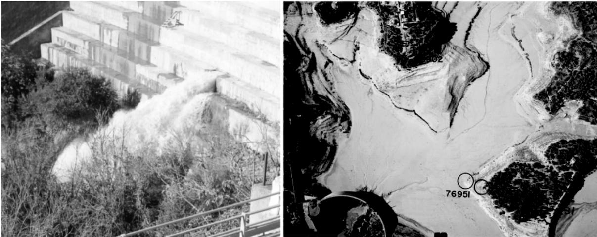
**Figura 3.** Foto izquierda: detalle de la fuga de agua en el paramento de aguas debajo de la presa. Foto derecha: estado del embalse después de su vaciado total
