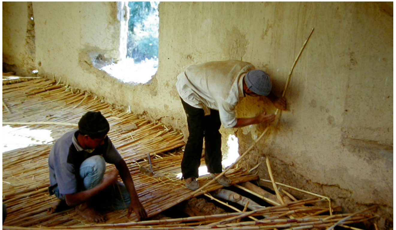
imagen_173 reconstrucción forjado
