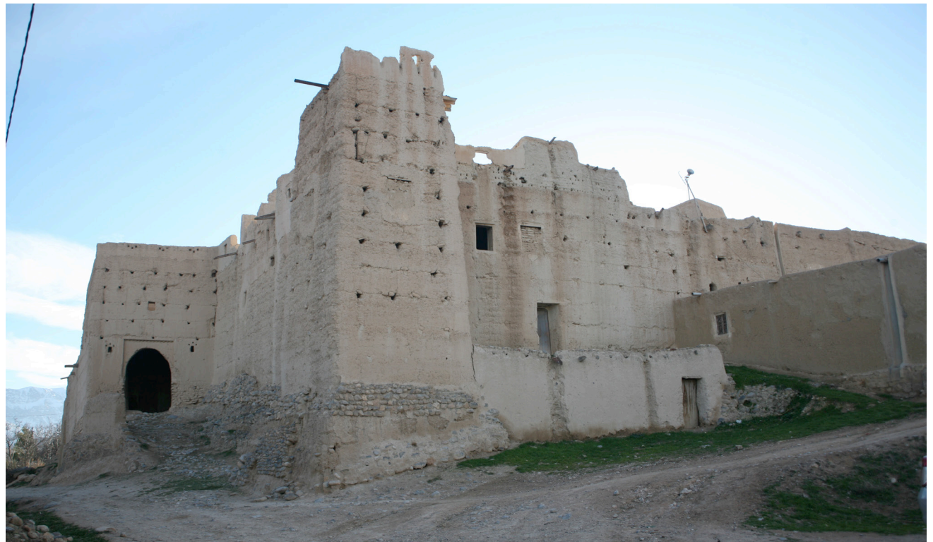
imagen_187 acceso ksar tabenatut
