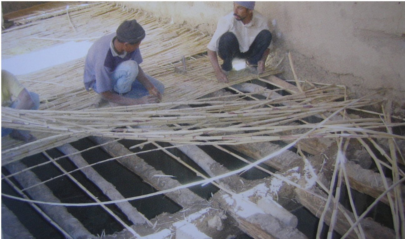
imagen_152 ejecución forjado
