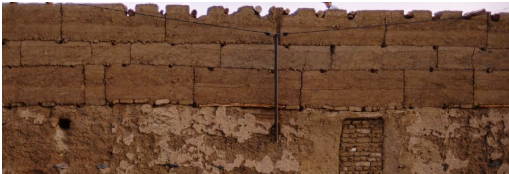
imagen_55 reconstrucción de muro tapial;
