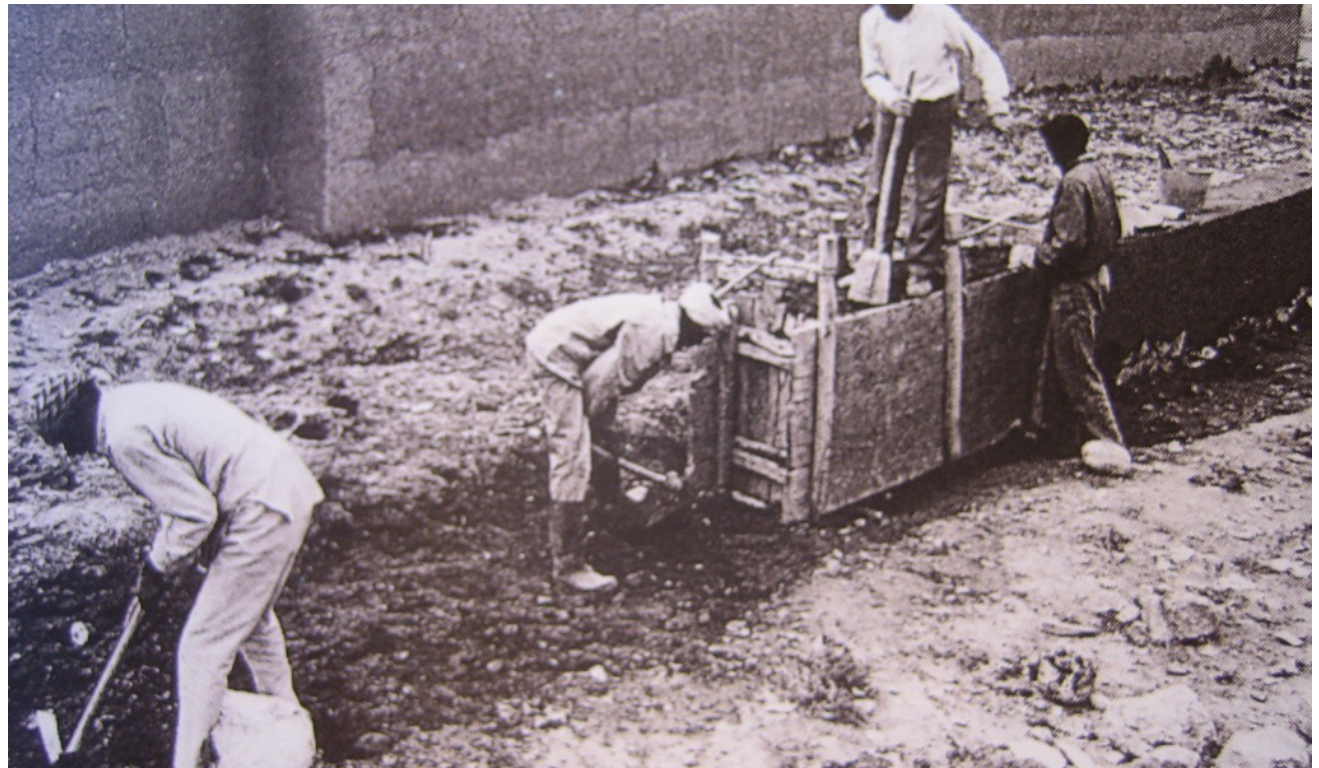
imagen_144 imagen trabajadores etapa cimentación
