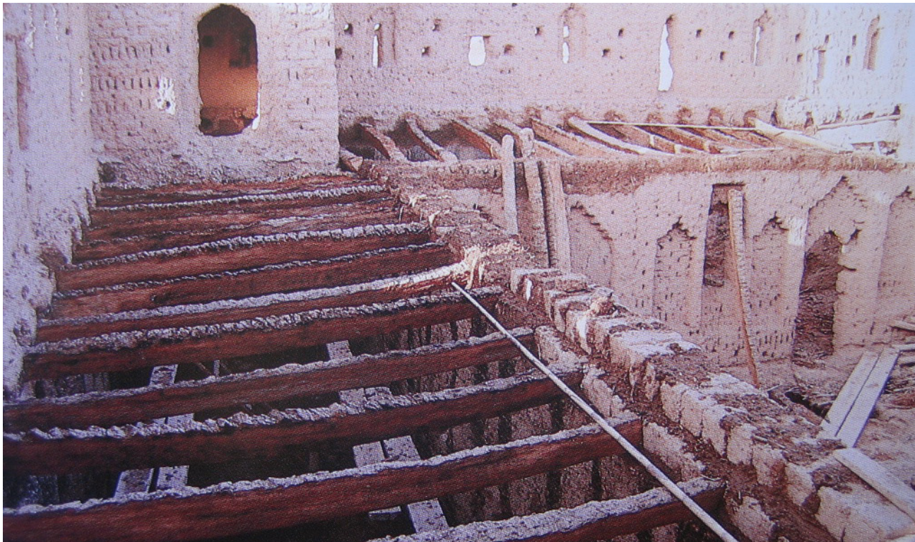
imagen_151 vista forjado cubierta de kasba
