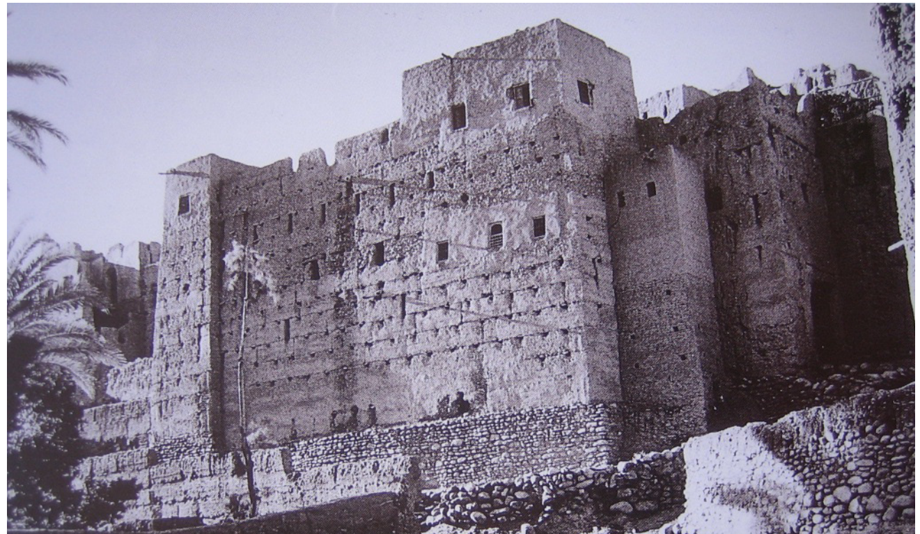
imagen_182 patología química debido a los agentes medioambientales
