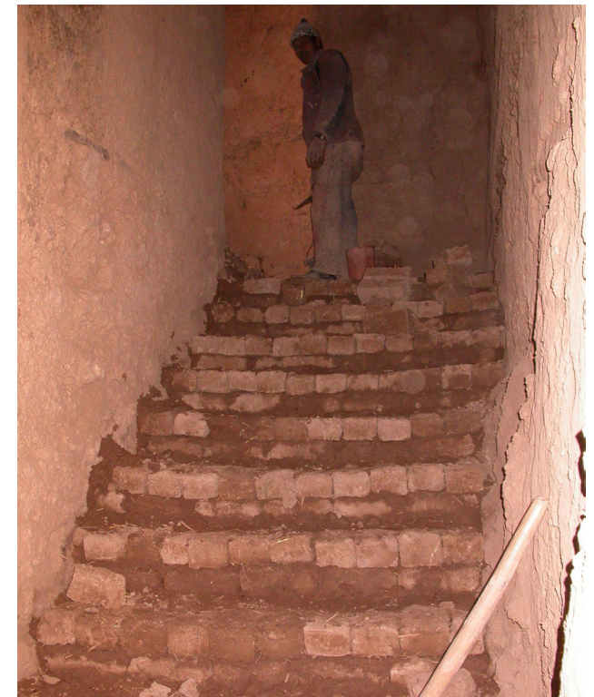
imagen_154 vista frontal escalera
