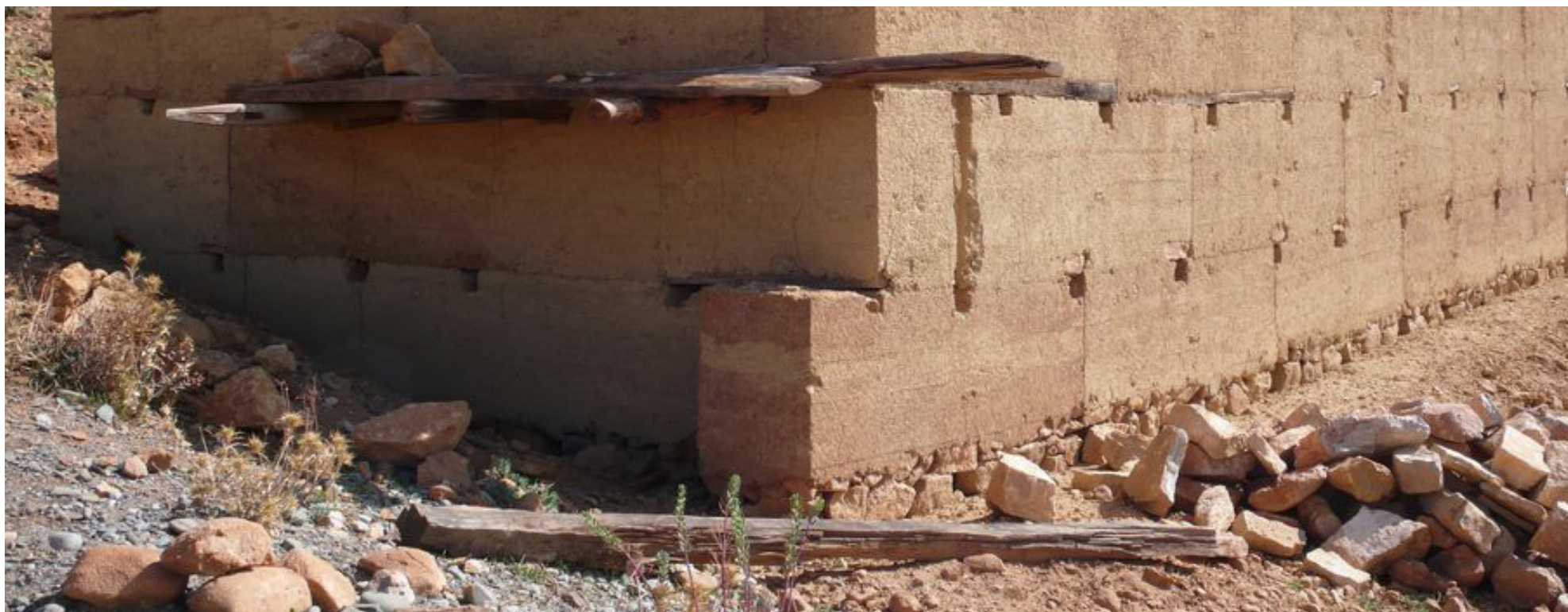
imagen_53 encuentro en esquina de muro tapial
