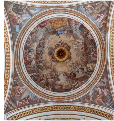
Fig 70. Detalle de la cúpula sobre pechinas que cubre la Capilla de la Comunión
