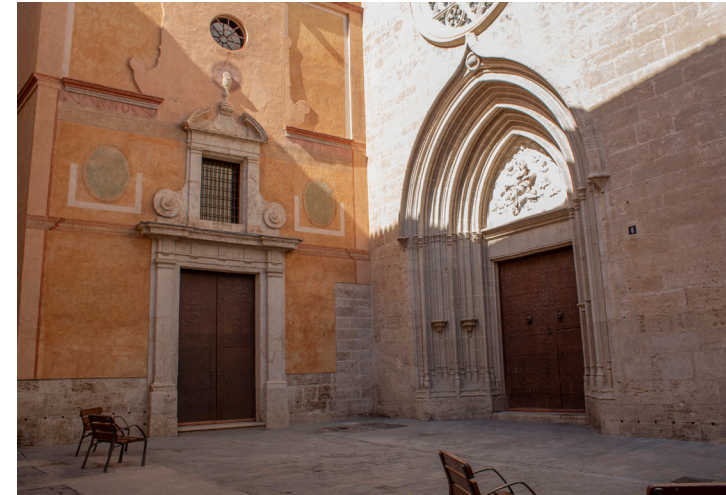
Fig 23. Encuentro entre fachada de la Capilla de la Comunión y fachada gótica
