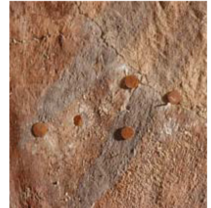
Fig 73. Detalle de clavos que sujetan el panel de madera a la bóveda
