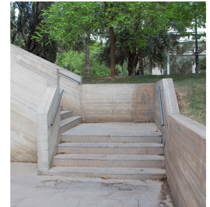
Fig 16. Escalera que conduce a los Jardines del Hospital
