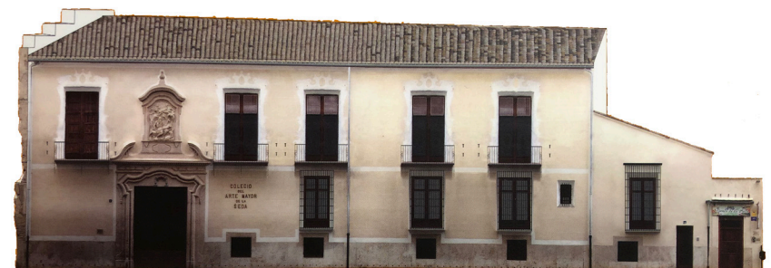
Fig 36. Fotoplano de la fachada principal
