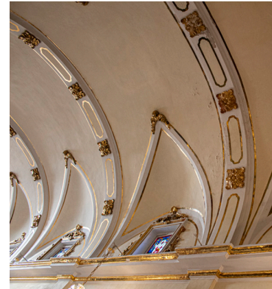
Fig 7. Detalle de arcos fajones en nave principal
