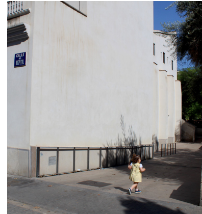
Fig 11. Nuevo acceso lateral
