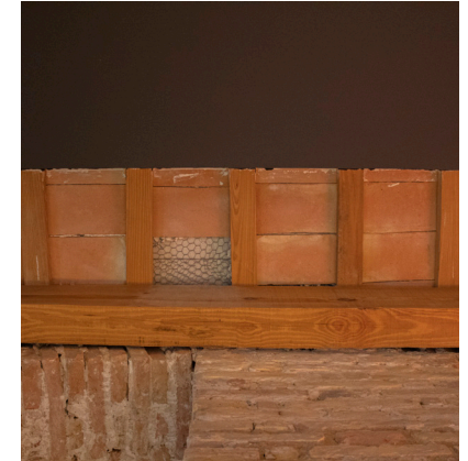
Fig 61. Cara inferior actual del primer forjado
