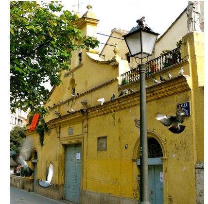
Fig 12. Fachada previa a la restauración
