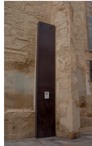
Fig 65. Muestra exterior del refuerzo estructural
