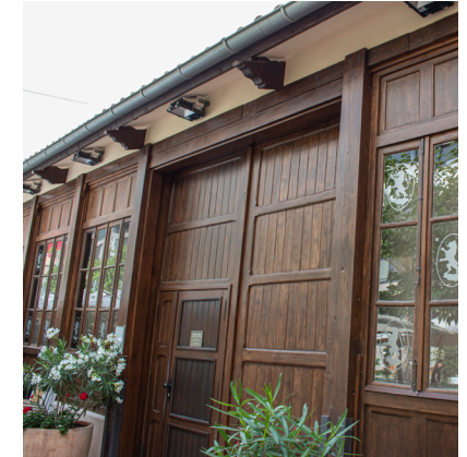
Fig 50. Fachada de las naves recayente al patio
