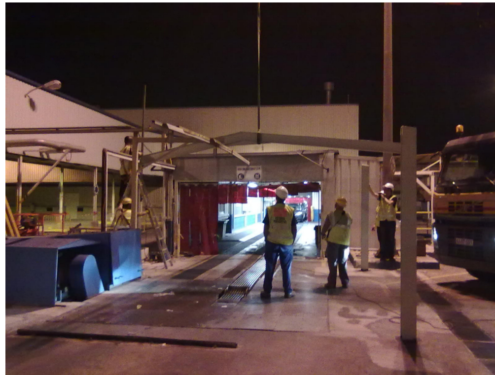
Colocación de la 1ª cercha
