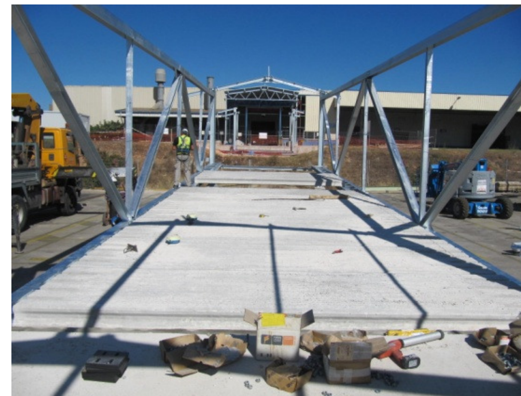
Colocación del tablero y armaduras de la capa de compresión.
