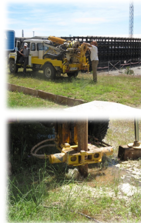
S-2 (zona talud):
