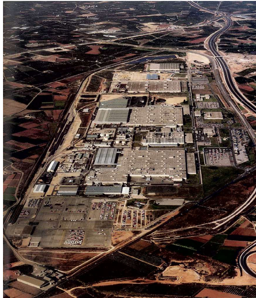
Fotografía aérea tomada en 1993 de la fábrica de Almussafes, cuya superficie total es de 2.734.620 m 2 .
