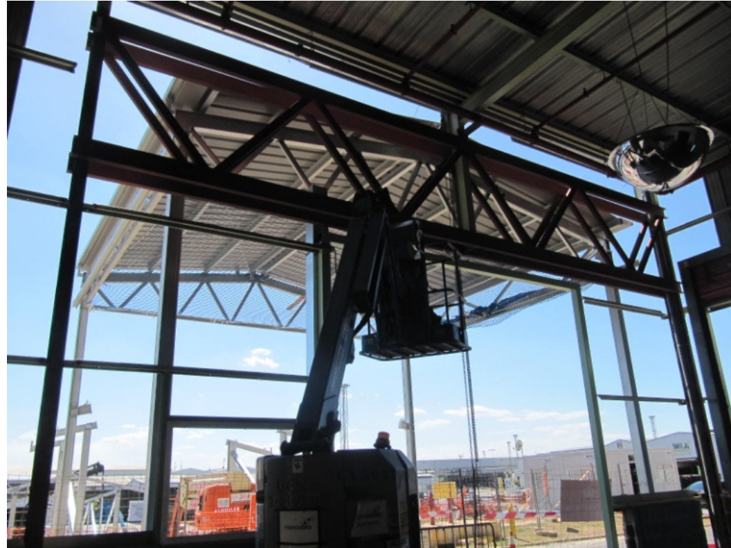
Apertura del nuevo acceso al edificio 171 (Carrocerías II), eliminando las chapas que formaban la fachada y su zócalo de bloque.
