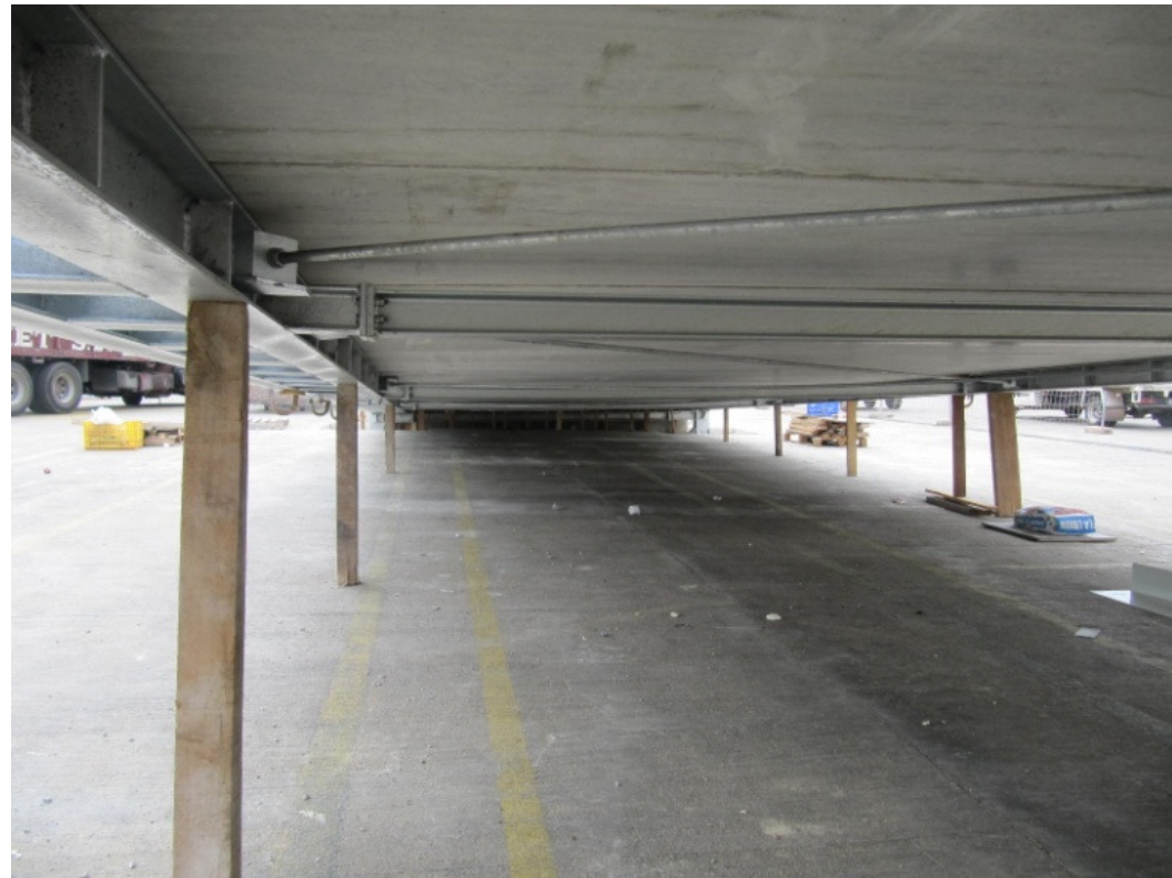
Parte inferior del tablero
