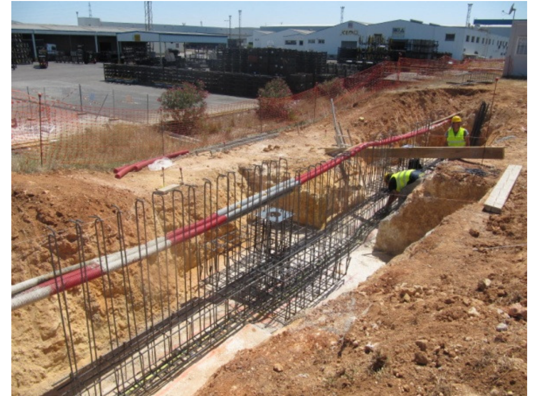
Colocación de armaduras de cimentación.
