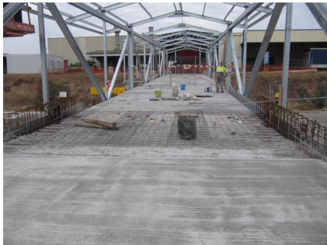
Colocación de las armaduras de los muretes laterales. A cada hendidura de la losa alveolar prefabricada se le coloca una horquilla de acero corrugado.
