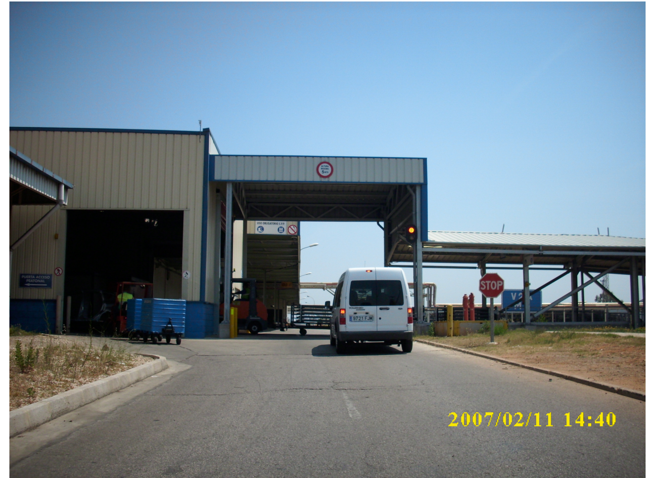
Covered way en funcionamiento (Zona talud)
