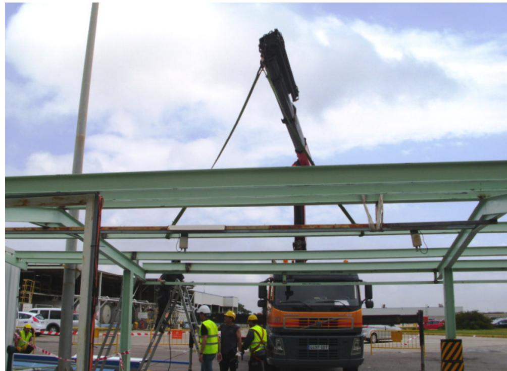
Trabajos de izado de elementos estructurales
