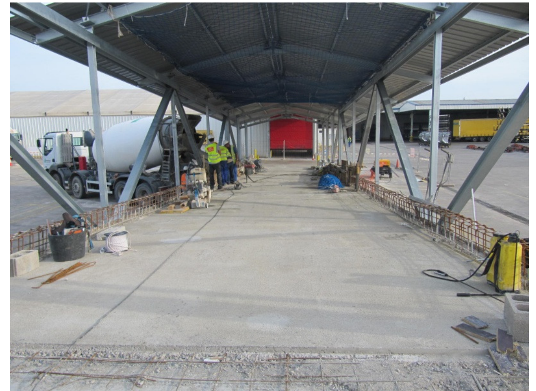
Preparación de la zona de vertido del hormigón.
