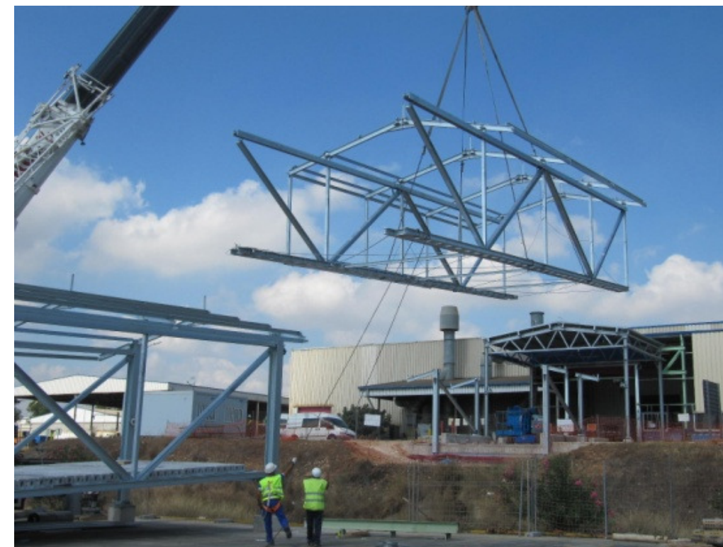
Izado de la estructura metálica de una de las partes del tramo intermedio.
