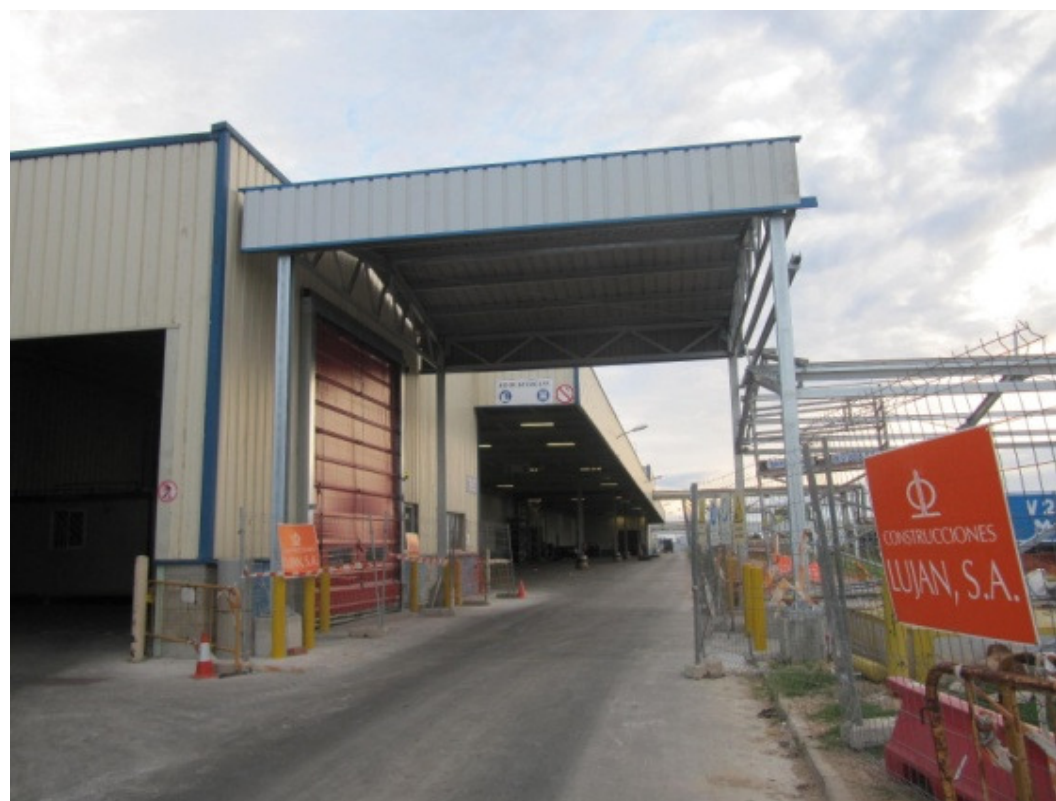
Canopy anexo al edificio 171.(Carrocerías II)
