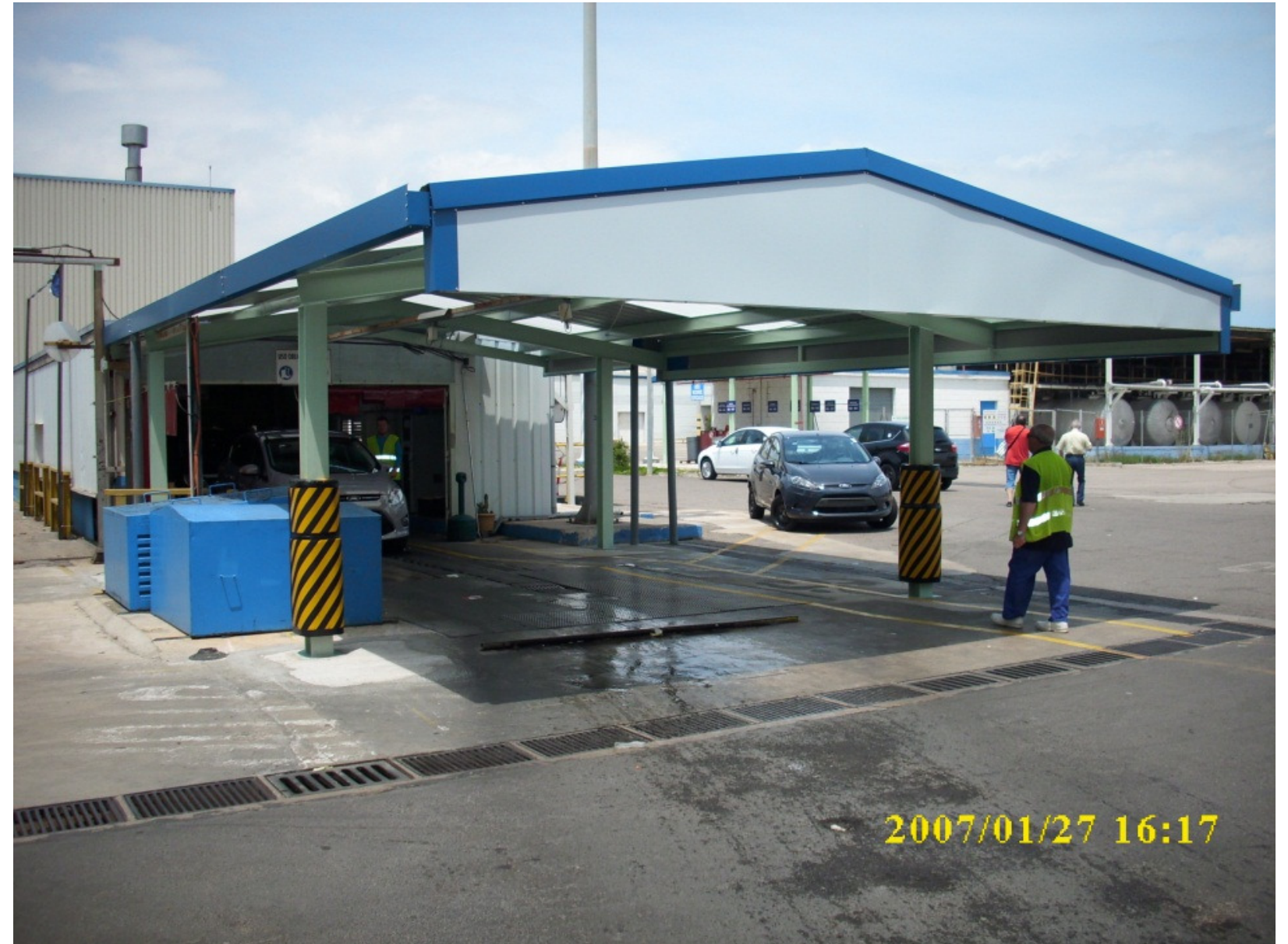
Marquesina finalizada. Ya en funcionamiento mientras sigue la producción de vehículos.
