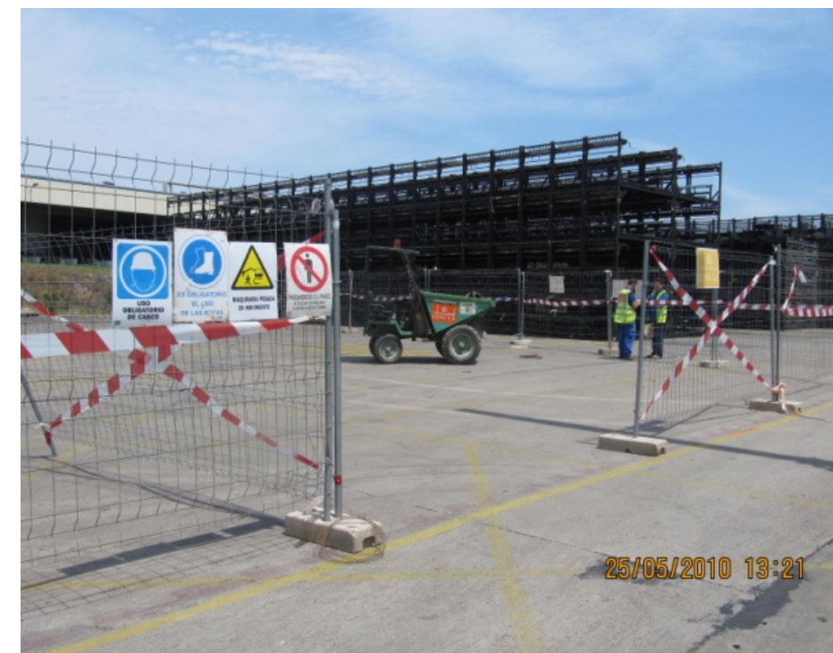
Vallado de obra con señalización
