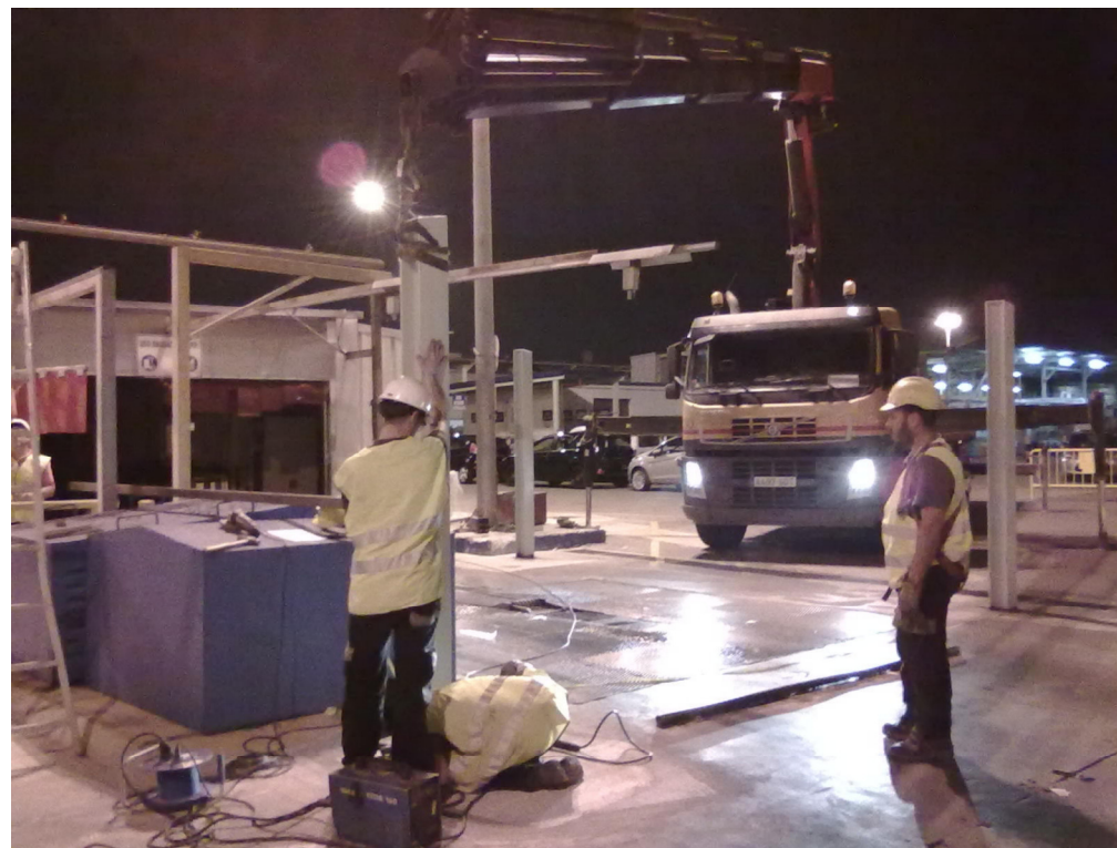
Colocación de pilares
