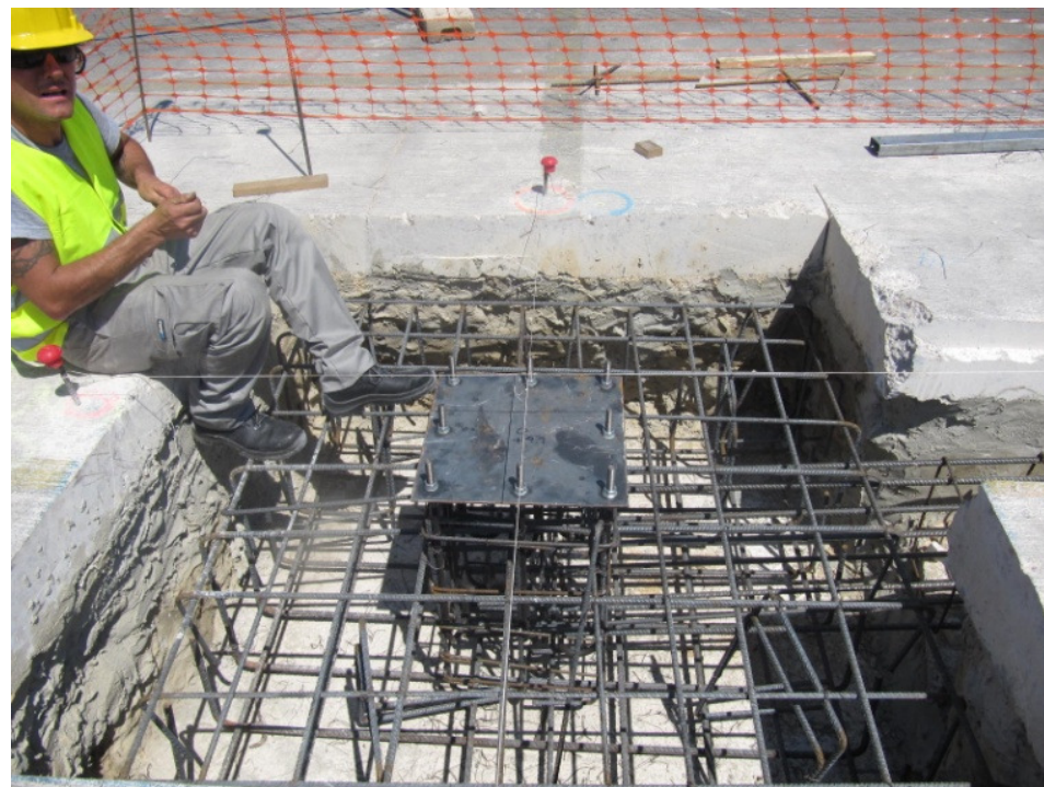
Nivelación de la placa de anclaje en zapata
