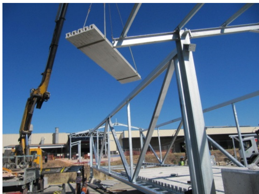
Alisado y colocación de las losas alveolares prefabricadas.
