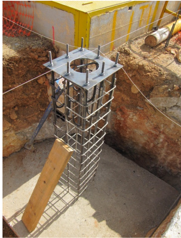
Nivelación de la placa de anclaje en enano
