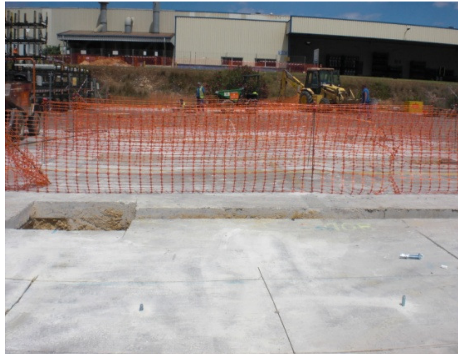
Corte de la solera existente para la futura excavación de la cimentación.
