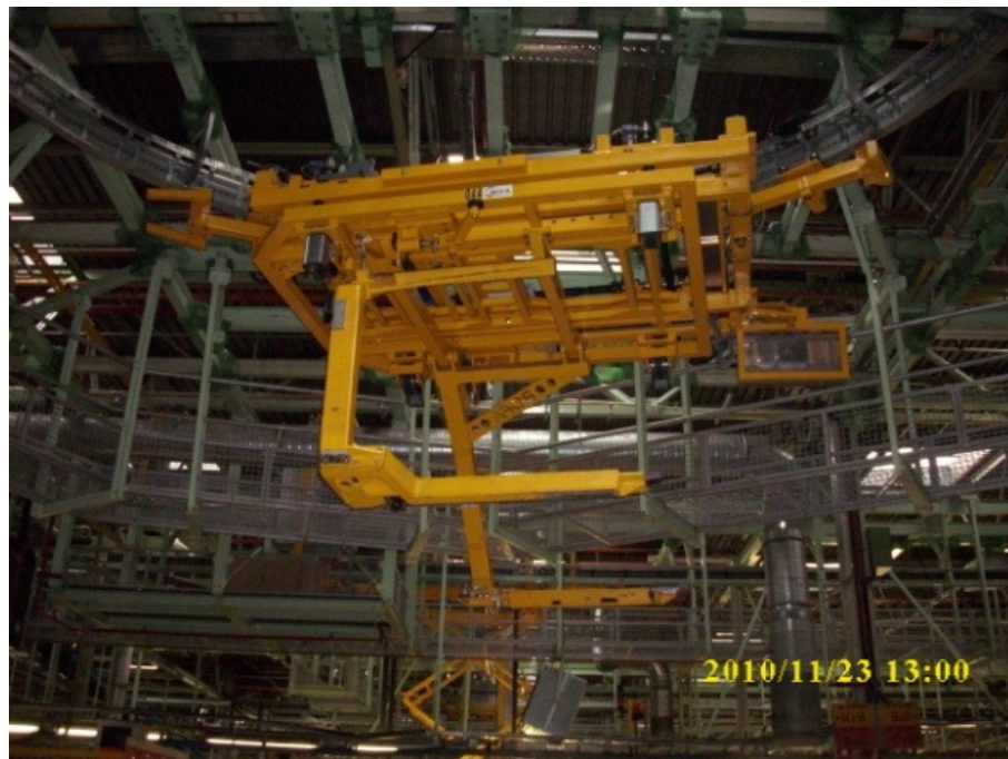
Fotografía de la electro-vía colgada
