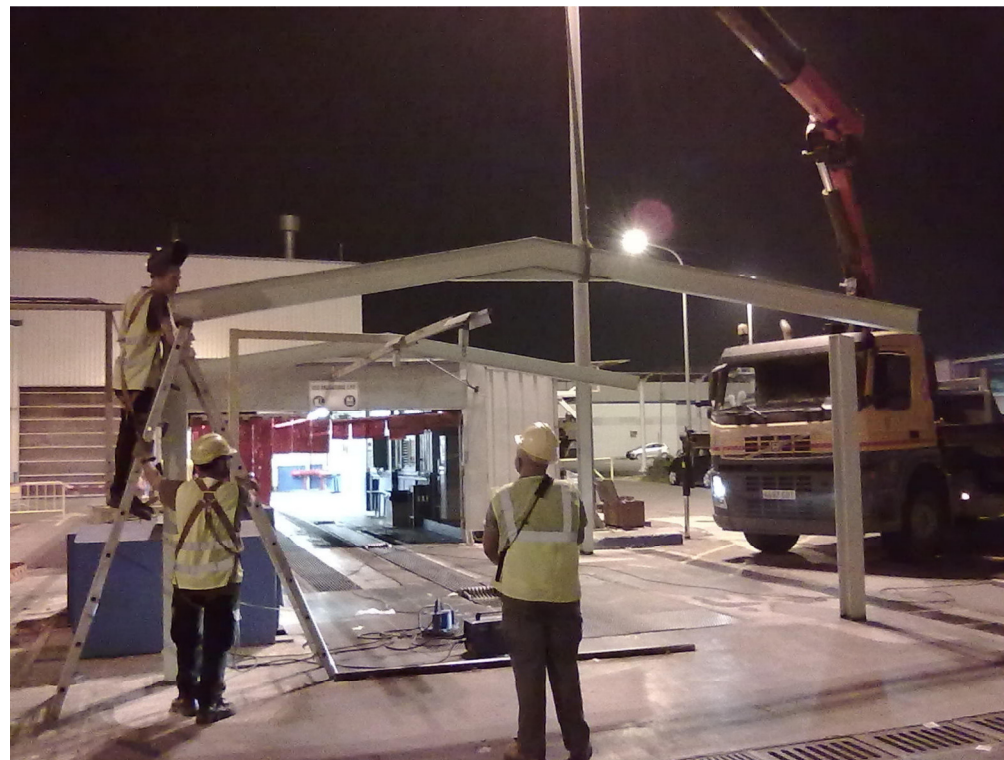
Colocación de la 2ª cercha
