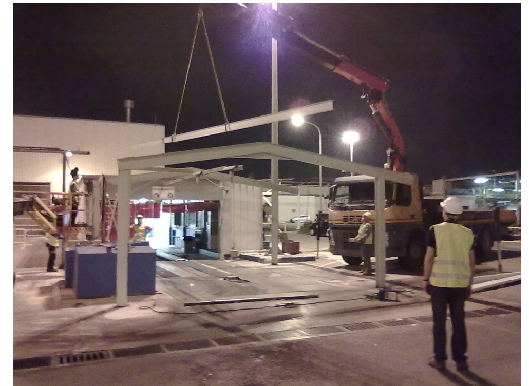
Colocación de la viga de arriostamiento o atado
