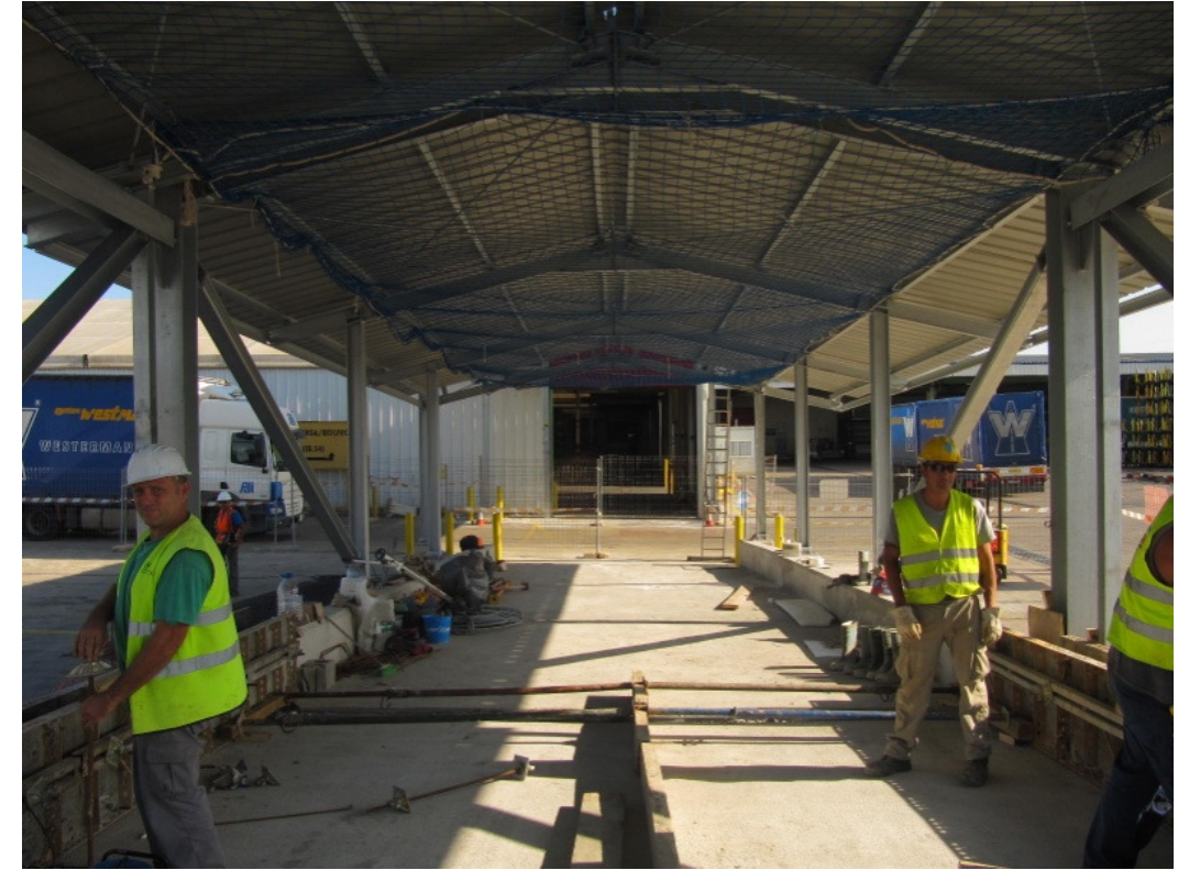
Apertura del nuevo acceso al edificio 171 (Carrocerías II), eliminando las chapas que formaban la fachada y su zócalo de bloque.
