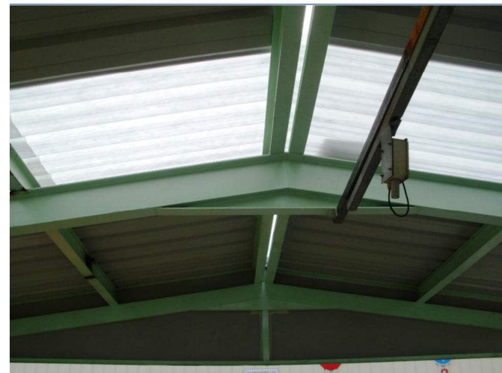
Chapas colocadas en la cubierta de la marquesina
