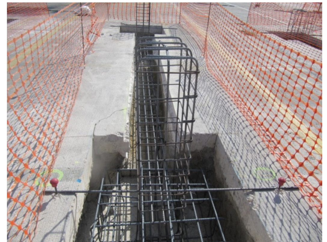
Colocación del armado de los enanos
