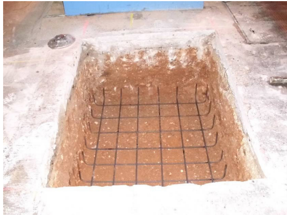
Colocación del armado (parrilla inferior) en cada una de las zapatas.
