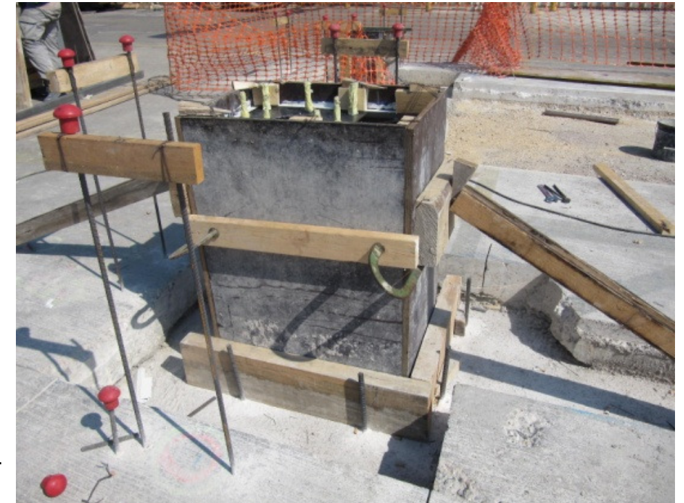
Encofrado del enano de cimentación.
