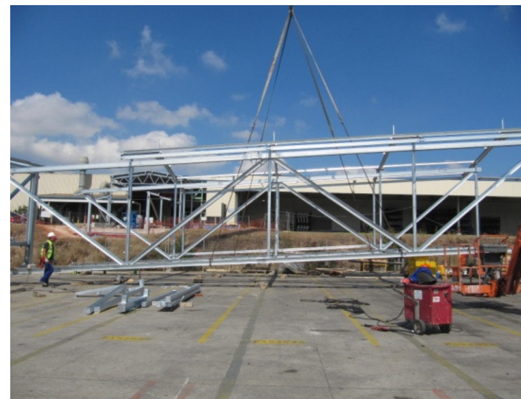
Colocación del tramo intermedio de estructura
