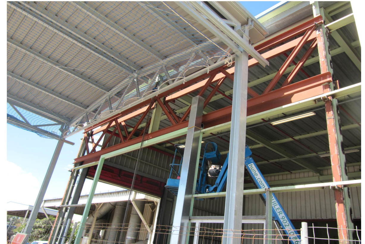
Apertura de hueco en fachada con refuerzo de viga de celosía tipo Warren y eliminación de soporte existente.
