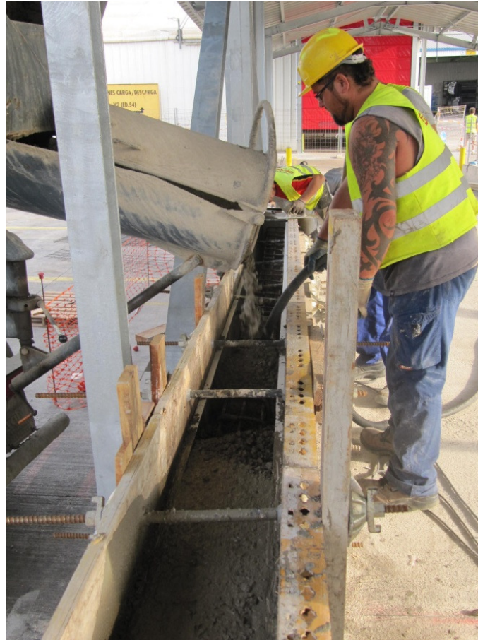
Operarios trabajando en el hormigonado de los muretes, efectuando su correspondiente vibrado.
