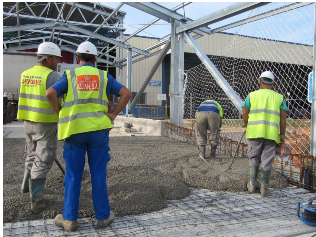
Hormigonado y vibrado de la capa de compresión del tablero.
