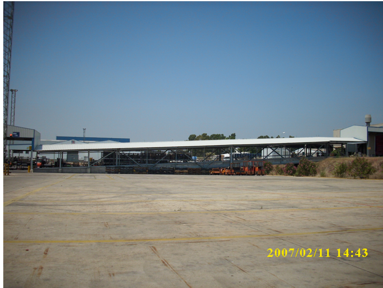
Covered way en funcionamiento (Zona explanada)
