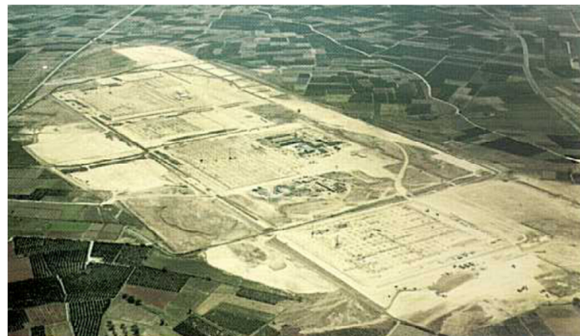
Trabajos de explanación, año 1974
