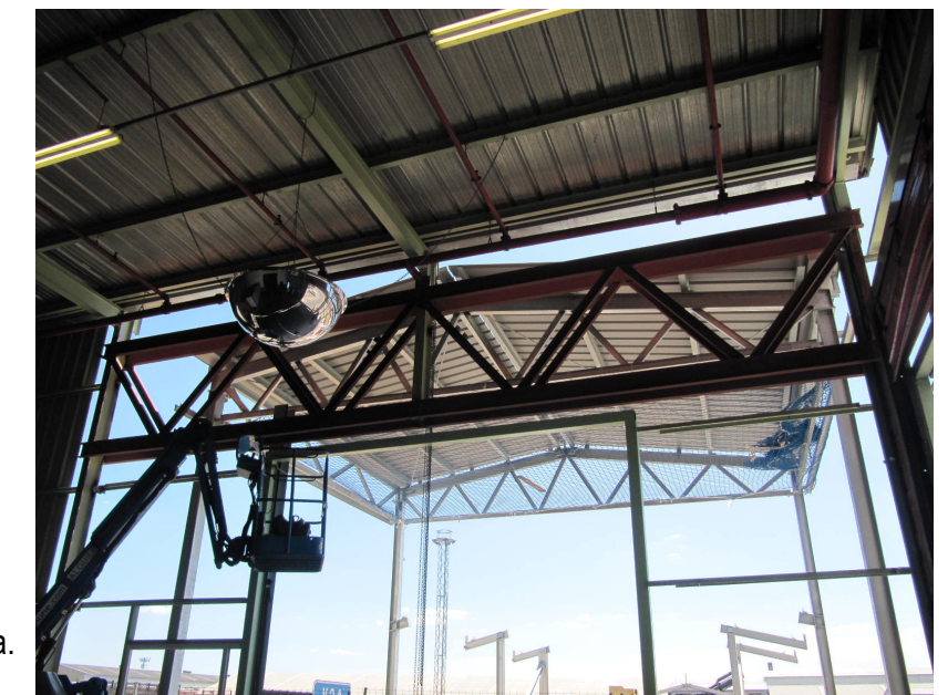
Apertura de hueco en fachada con refuerzo de viga de celosía tipo Warren y eliminación de soporte existente.
