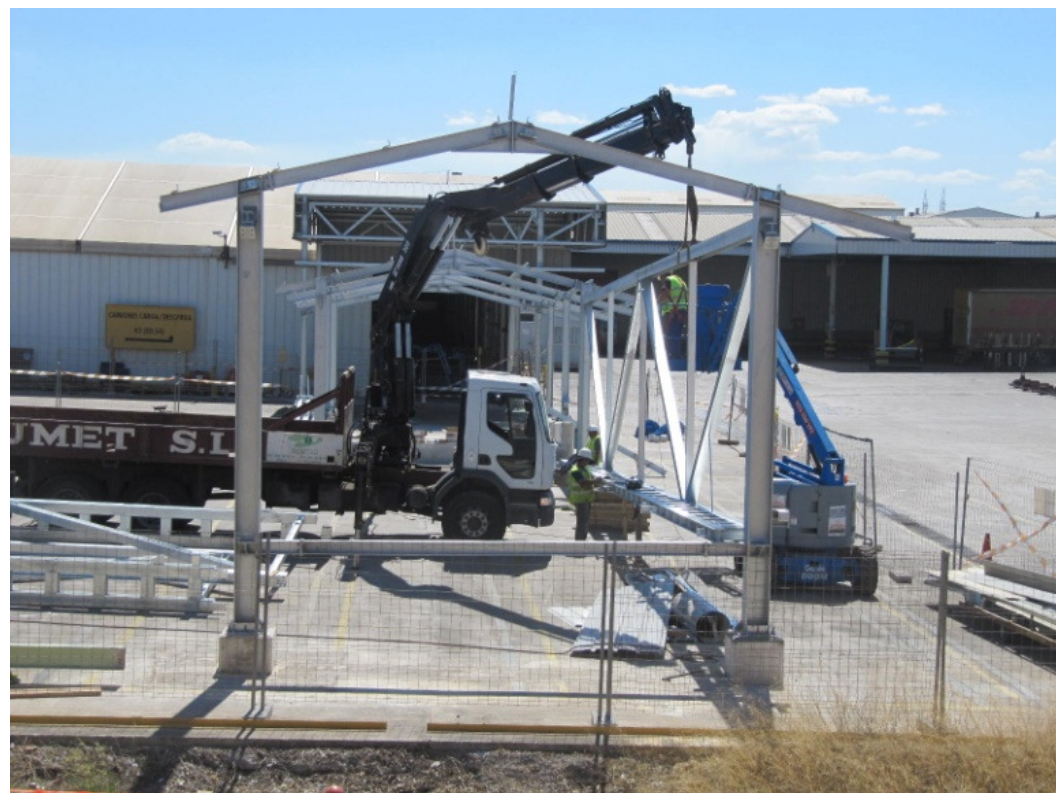
Descarga y puesta en obra de las diferentes partes de estructura metálica conformadas en taller, mediante camión con grúa pluma telescópica incorporada.
