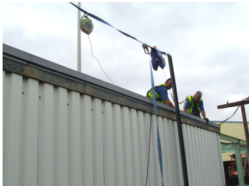
Trabajadores en cubierta realizando trabajos de sustitución de chapas. Uso correcto del sistema Anti-caídas completo, atados en todo momento a la línea de vida instalada.
