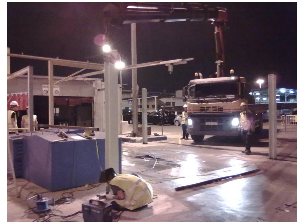
Soldadura del pilar a la placa
