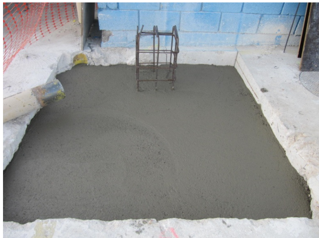
Resultado de hormigonado en una zapata ex-céntrica
