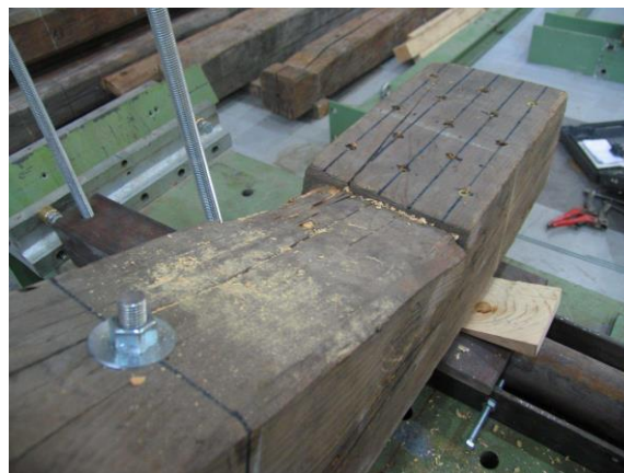
Figura 33. Sección de otra de las vigas de madera antigua analizada en Branco et al. (2010).
