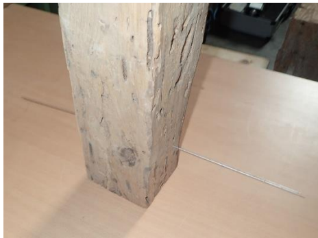
Figura 1. Broca resistográfica en el interior de la probeta. Fuente: Elaboración propia.
