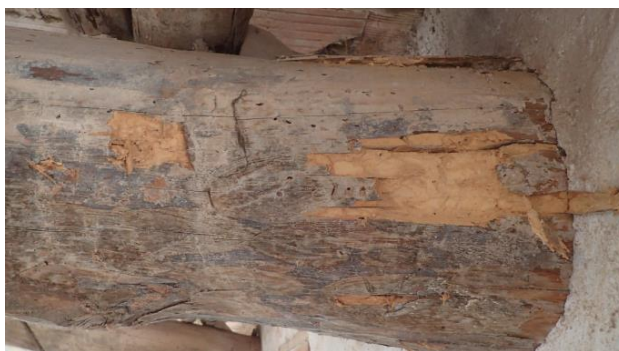
Figura 71. Ataque producido por cerambícidos. Fuente: Elaboración propia.
