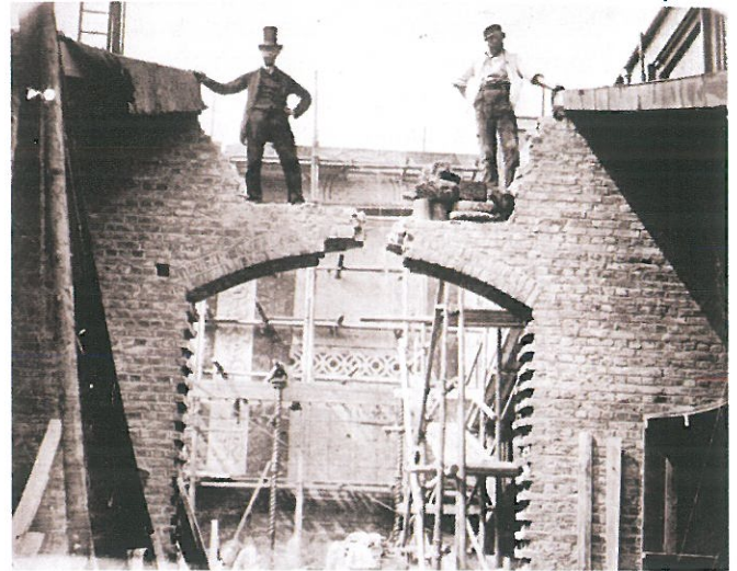
Fig. 5. Ensayo experimental de resistencia de un nuevo cemento por el capitán Henry Scott, 1861, Science Museum, Londres.
