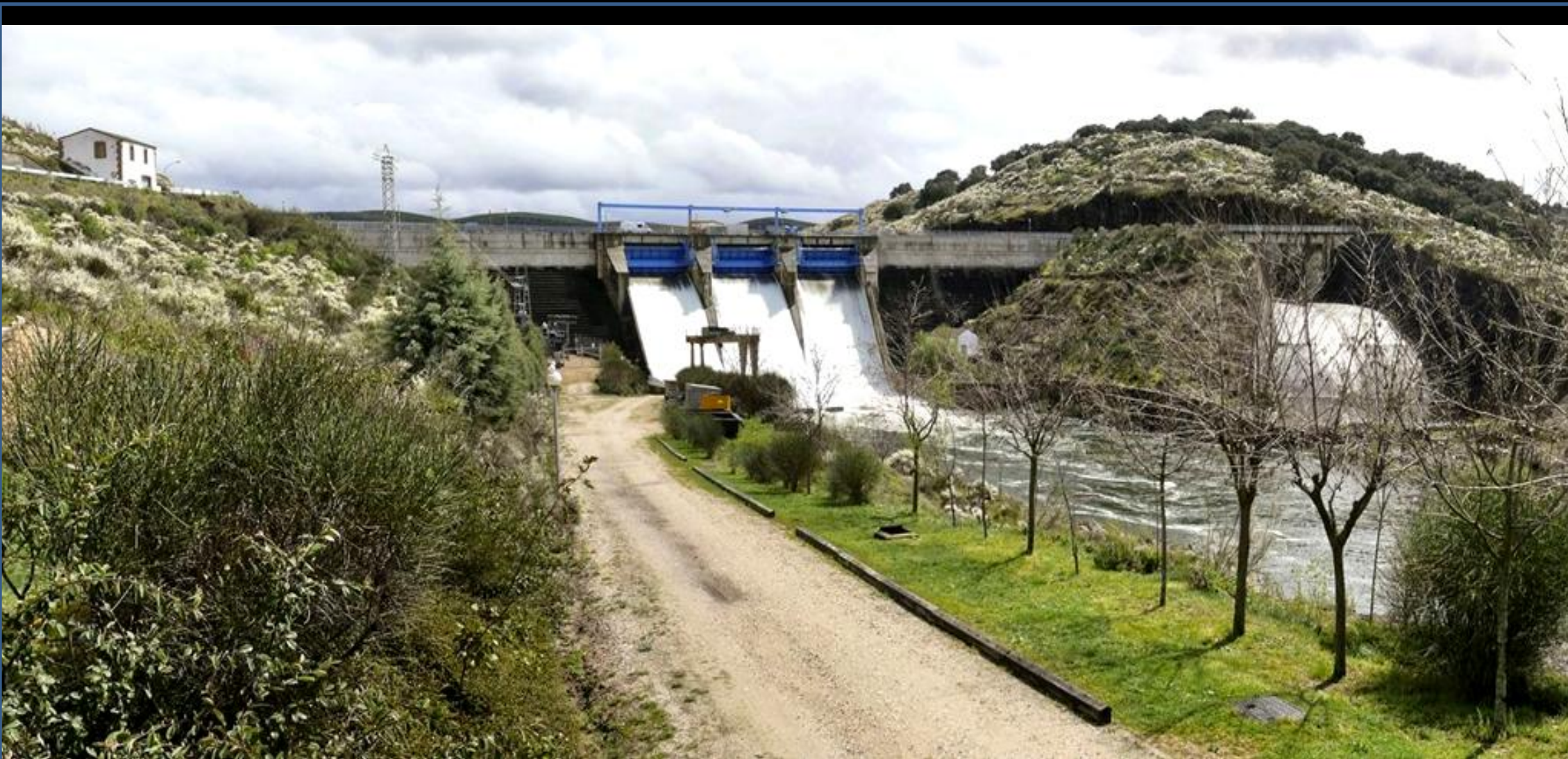
Presa del Águeda, en Zamorra, entre pizarras y grauvacas del Precámbrico Sup. SE Hoja de Serradilla del Arroyo. (por JNacho-Google)
