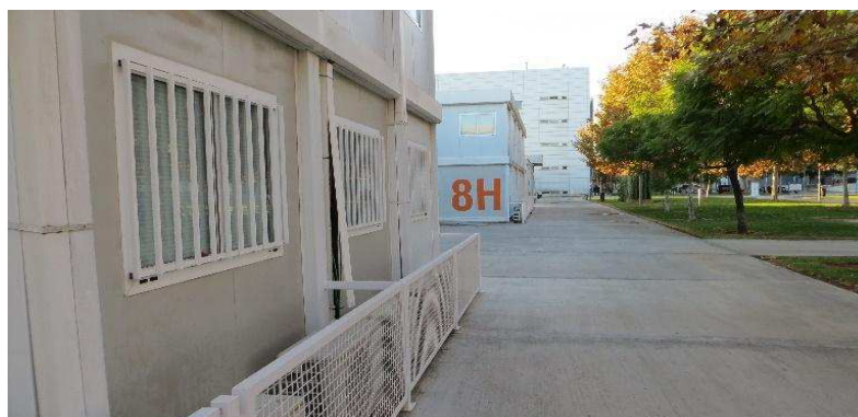
Imagen 15. Edificios con producción propia mediante equipos VRV
