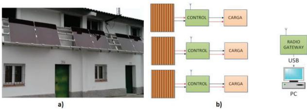
Figura 15: Instalación fotovoltaica experimental con módulos de capa fina (a) y diagrama de bloques (b).
