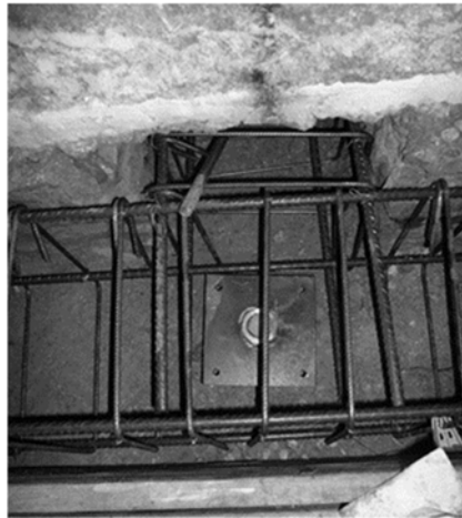
Figura 7. Recalce con micropilotes (encofrado discontinuo con vigas pasantes)
