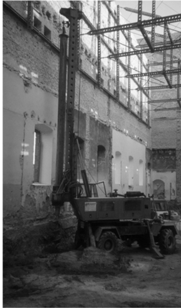
Figura 2. Maquinaria para ejecución recalce con pilotes in situ
