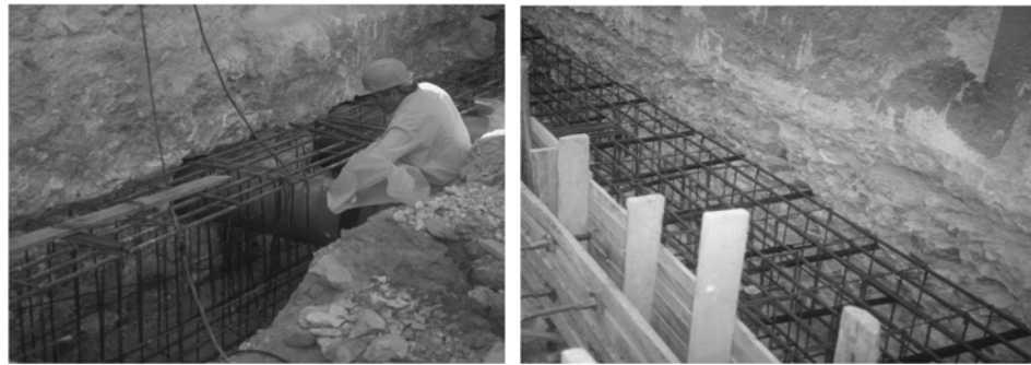
Figura 3. Recalce mediante pilotes in situ (S. Miguel de los Reyes, Valencia)
