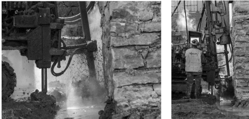
Figura 7. Ejemplo de aplicación de la técnica de Jet-grouting [9]
