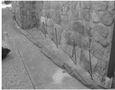
Figura 4. Inyecciones de compactación, zapata corrida vivienda unifamiliar [11]
