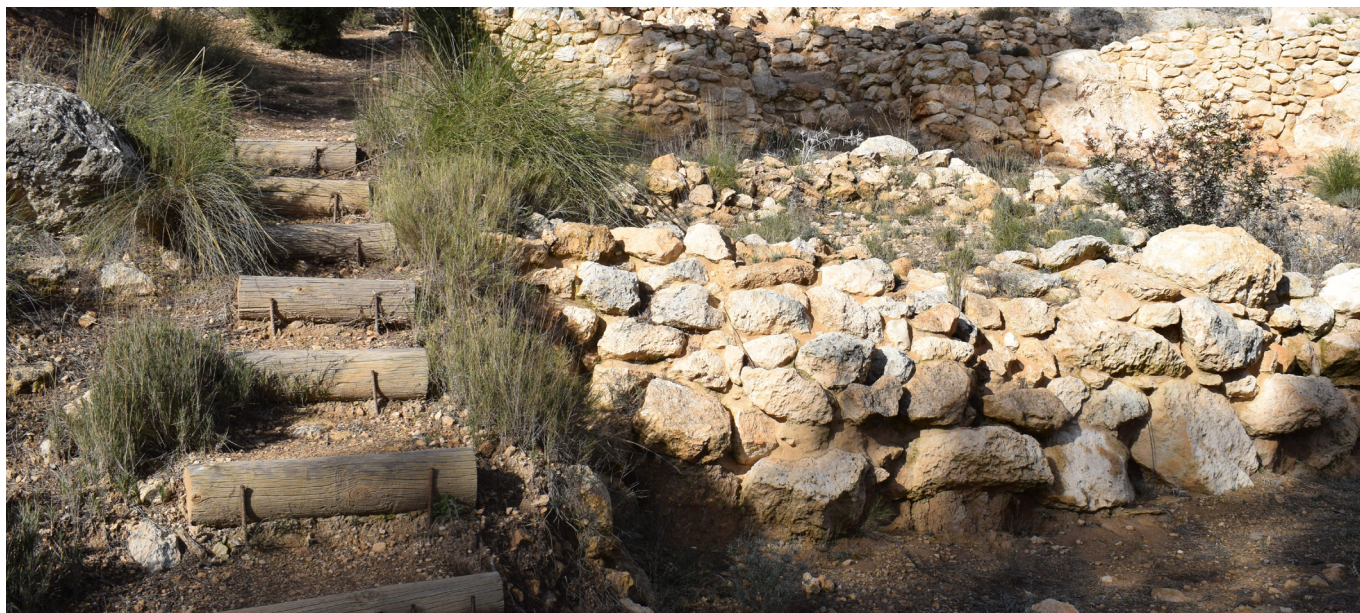
Figura 15. Acceso a los muros aterrazados.
