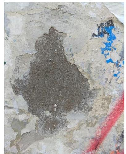
(Fig. 49) Detalle de daños, descamación, faltantes, grafiti. Fotografía personal. 2019
