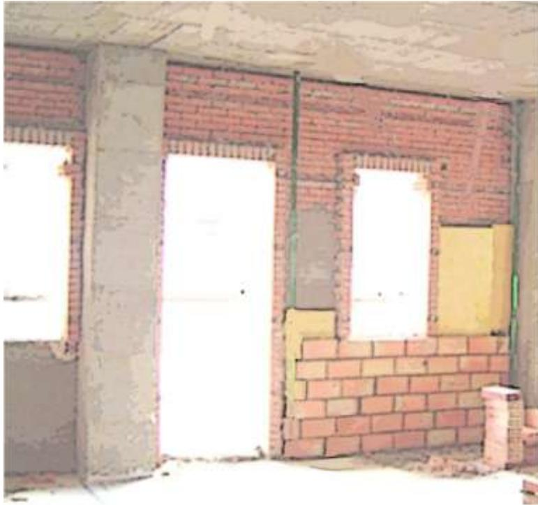
Figura 3. Construcción de fachada tradicional. Fuente: elaboración propia
