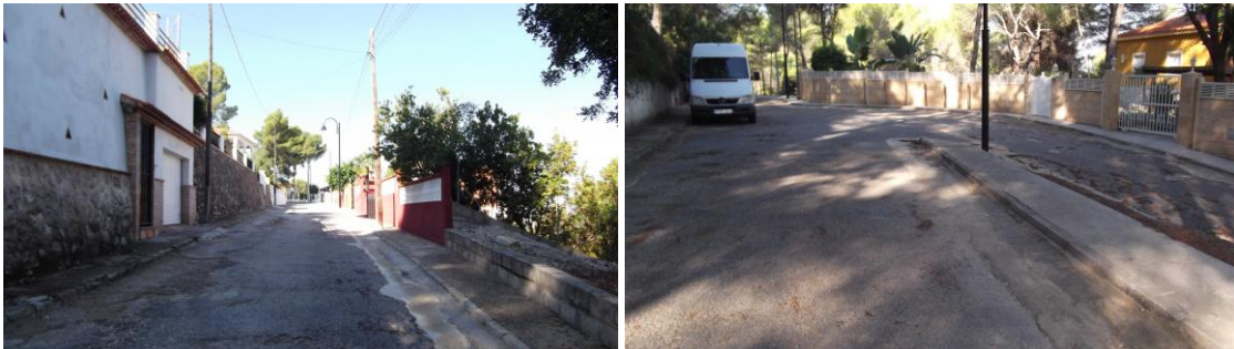
Imagen 33. Detalle viales internos de doble sentido.
