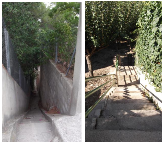
Imagen 36. Ejemplos de sendas asfaltadas peatonales. Foto Izquierda: no recomendada para la evacuación. Foto derecha: Si recomendada para la evacuación.
