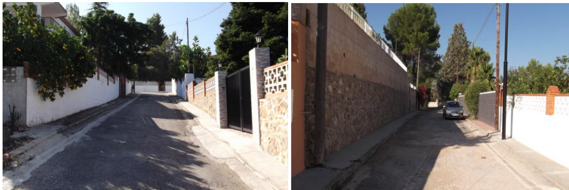
Imagen 32. Detalle viales internos de doble sentido.
