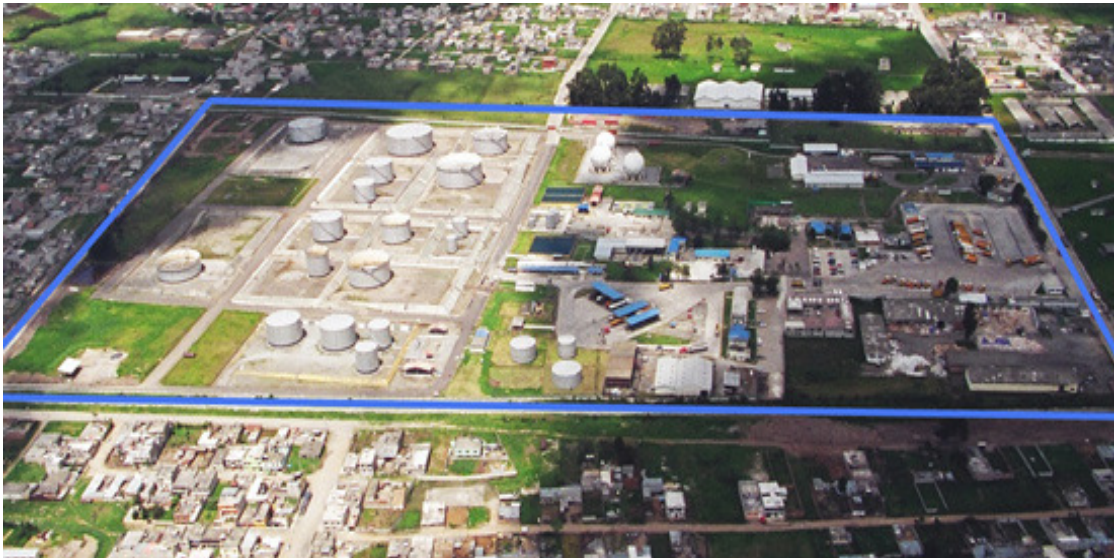
Fotografía N°4.3 Vista Aérea de la Terminal de Productos Limpios El Beaterio
