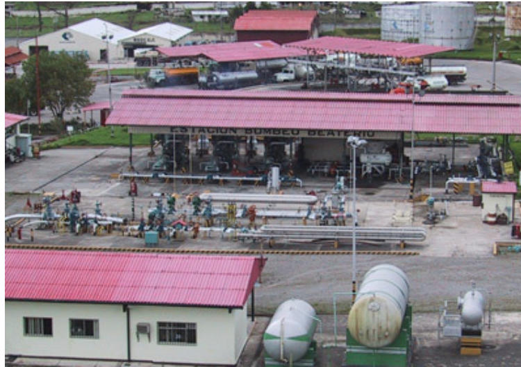
Fotografía N° 4.8 Estación de Bombeo
