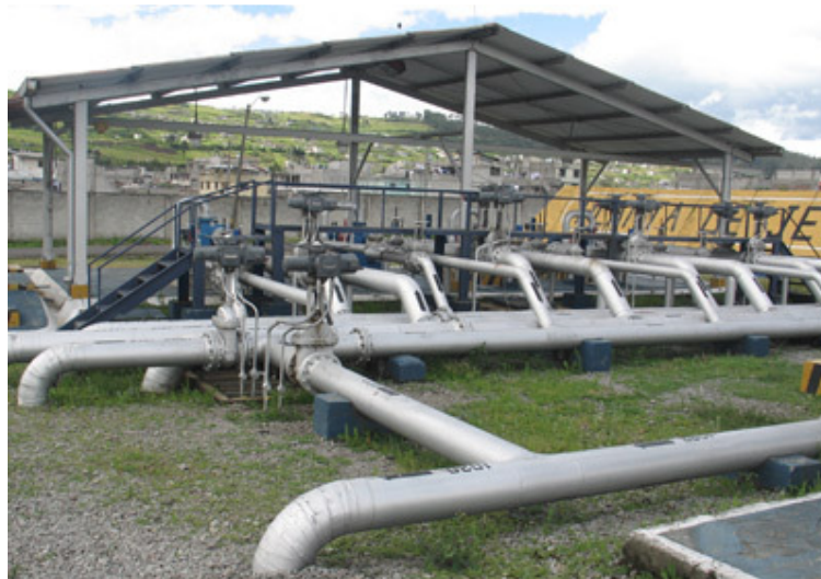
Fotografía N° 4.7 Estación Reductora
