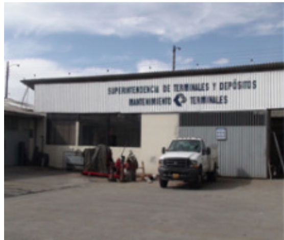
Fotografía N° 4.9 Talleres de Mantenimiento
