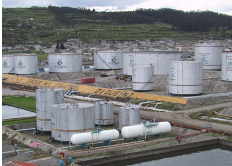
Fotografía N° 4.4 Área de Almacenamiento
