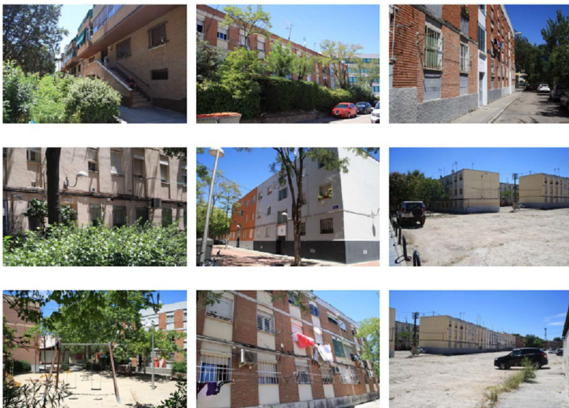
Fig. 3. Imágenes del estado actual del barrio del Aeropuerto. Fuente propia
