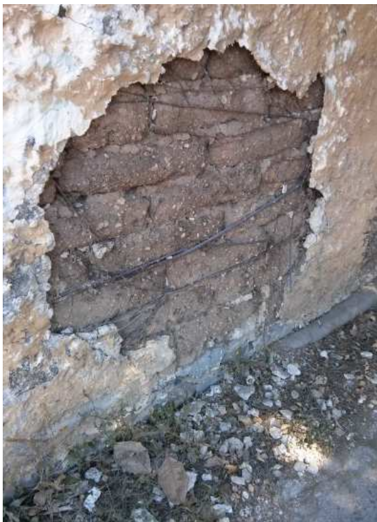
Fig. 2. Detalle de muro. Fuente. Fotografía propiedad del señor Alfred Esteller.
