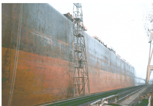
c) Superficies verticales. Dique seco.
