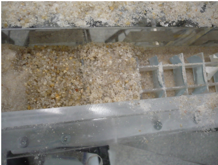
Figura 3.7 – Detalle de la operación de relleno húmedo con la plantilla
