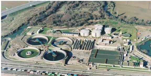
Fig. 9. Depuradora de aguas residuales de Crispijana (Vitoria), de 5000 m<sup>3</sup>/h. Cortesía de AMVISA.
