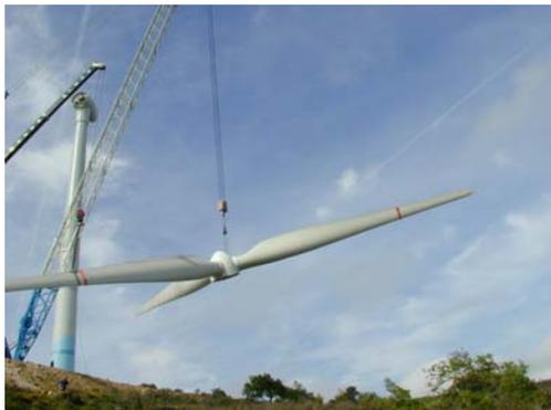
Fig. 10. Aerogenerador de 1650 kW de potencia gobernado con QFT (Parque de Unzué, Navarra). Cortesía de M.Torres.
