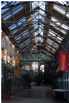
23-24 Recuperación de antiguas instalaciones industriales para uso cívico. Fotografías: Stadtteilarchiv Ottensen.
