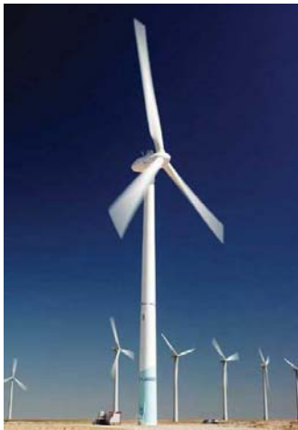
Fig. 14. El aerogenerador TWT en operación en el parque eólico de Cabanillas, Navarra. (M.Torres).
