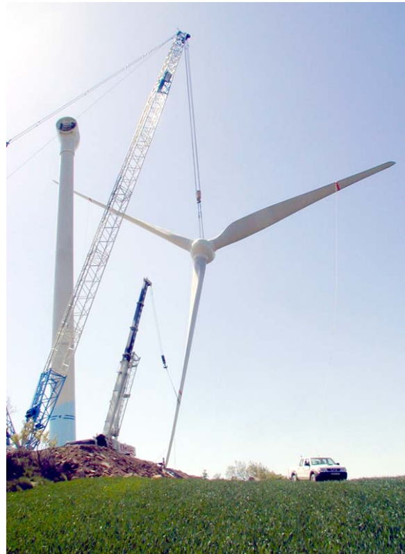
Fig. 1. Montaje del Aerogenerador TWT. Parque eólico de Unzué, Navarra. (Cortesía de M.Torres).
