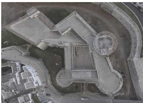
Fig. 4. Otranto (LE), configurazione planimetrica del Castello e del fossato (Baldassarre, et al. , 2018).
