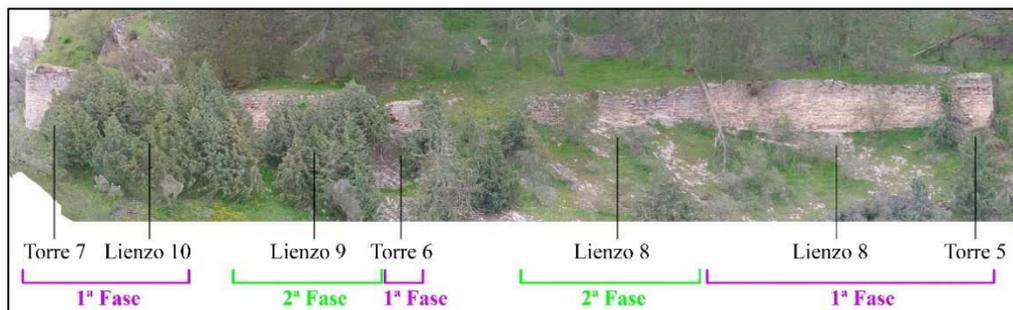
Fig. 4. Alzado del tramo T5-T7, con lienzos de muralla de la 1ª y 2ª fase constructiva.
