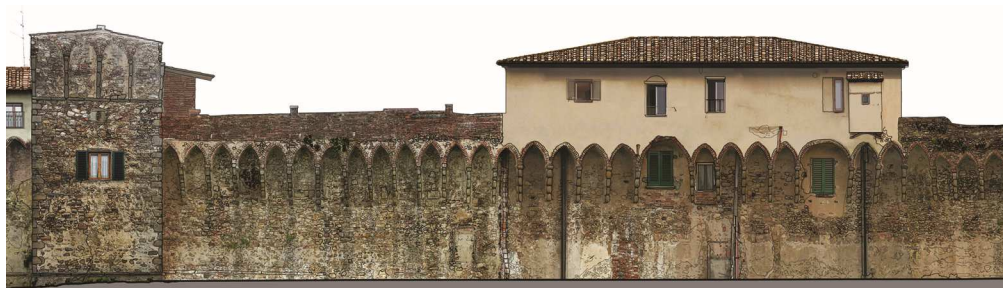
Fig. 5. Porzione di fotopiano del prospetto nord.
