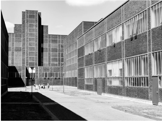
Fig. 1. Zollverein. Casa de la Caldera. Foto RD
