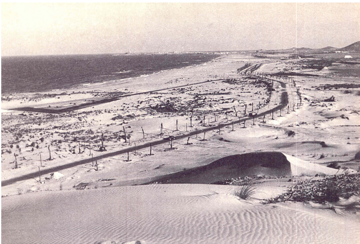
Fig. 1. Duna infinita entre dos mares. La Manga del Mar Menor. (Fuente: Archivo histórico del Colegio de Arquitectos de Cataluña)
