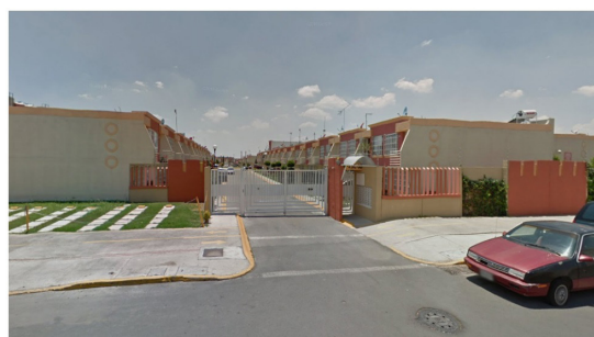
Fig. 5. Calle con acceso restringido. Ojo de Agua, México.
