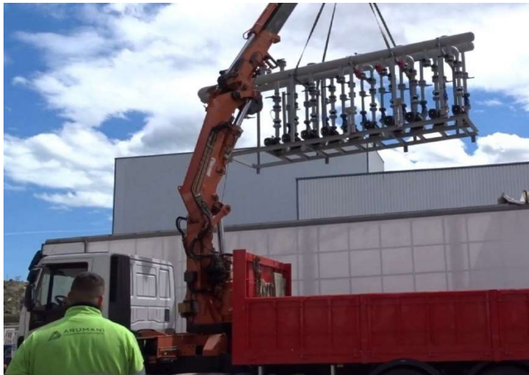
Fig. 3 Proceso de carga de skid montado y pre-fabricado, listo para transporte, con estructura auto-portante. Fuente: Arumani. (2019)
