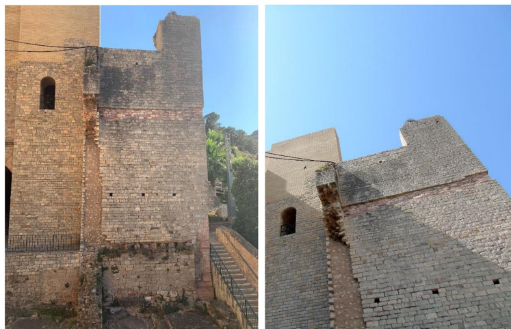
Figura 3. Imágenes del muro seleccionado del el Teatro Romano de Sagunto. Fuente: Elaboración propia.
