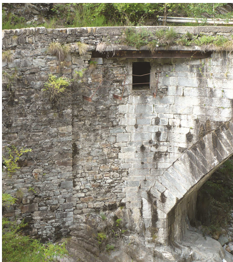
Fig. 9. Ponte con “fornello” in Valle Vigezzo (si ringrazia per la foto Pier Antonio Ragozza).
