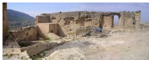
Fig. 2. Espacio interior, previo a la intervención (Miguel del Rey, 2009).
