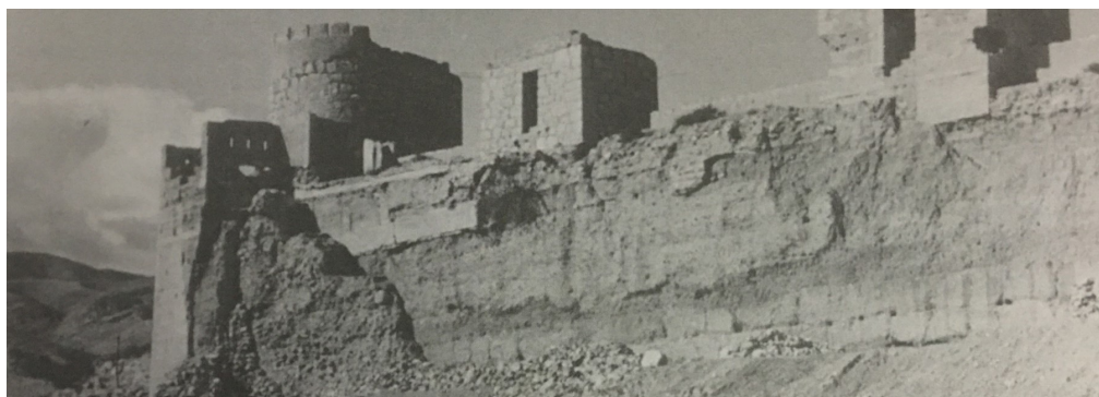
Fig. 4. Muralla del Cerro de San Cristóbal, tramo Torre 1 a Torre 3, vista intramuros. Colección F. Ochotorena, 1955.
