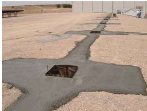
Figura 25: Cimentación vigas de atado
