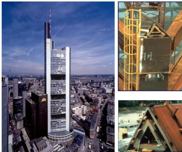
**Figura 2-2.** Torre Commerzbank: edificio más alto de Europa hasta 2005, construido con pilares mixtos de tipo perfil tubular de sección triangular rellenos de hormigón. Hanswille [93].
