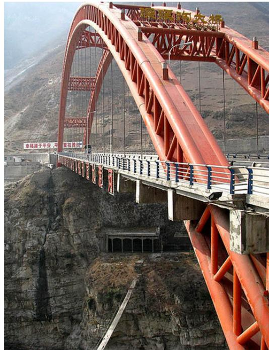
**Figura 2-6** . Vista de un puente sobre el río Gantse cuyos arcos son CFTs.
