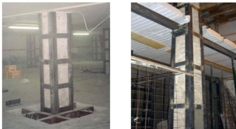
**Figura 3-1.** Pilares de hormigón empresillados: perfiles angulares en las esquinas y platabandas.
