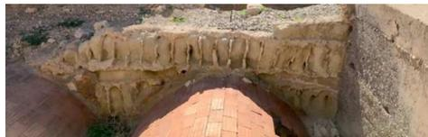
Fig. 2. Muro de soga y tizón califal en el segundo recinto de la alcazaba (P. Gurriarán).
