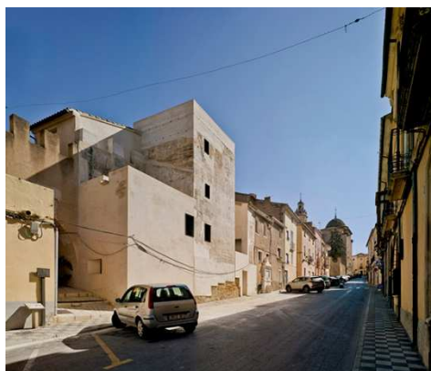
Fig. 5. Torreta, estado tras la intervención (David Frutos, 2018).
