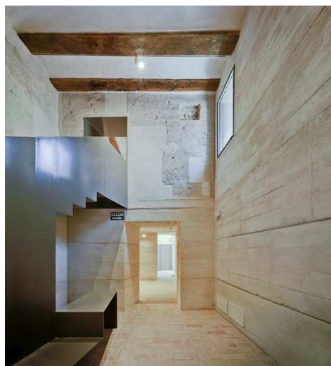
Fig. 10. Torreta, estado tras la intervención (David Frutos, 2018).
