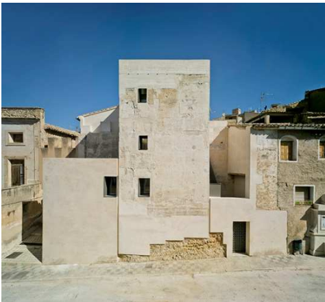
Fig. 6. Torreta, estado tras la intervención (David Frutos, 2018).
