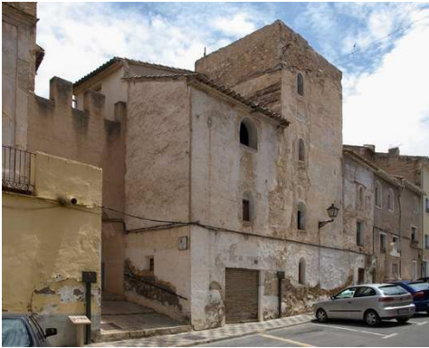
Fig.1. Imagen de la Torre de Jesús previa a la intervención (Miguel del Rey, 2009).
