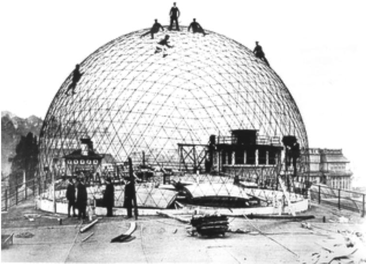
Fig 1.15 - Imagen de la estructura autoportante de la cúpula Zeiss durante su construcción (1922)
