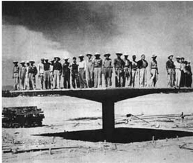
Fig 3.45 - Imagen del prototipo de paraguas invertido
