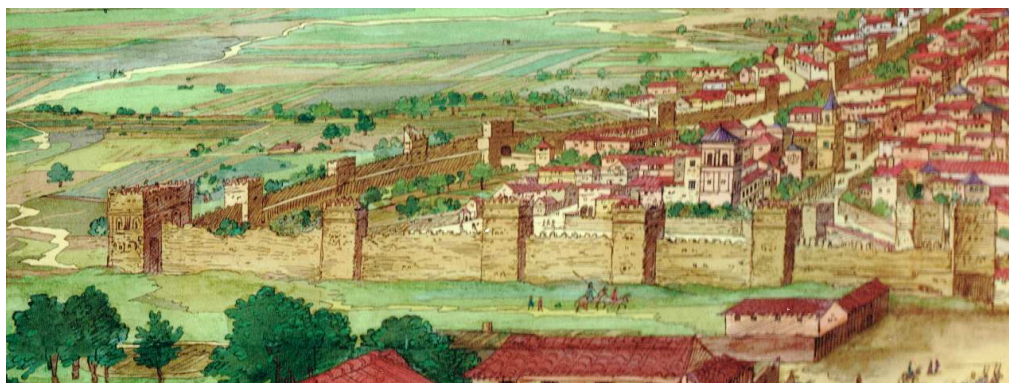
Fig. 1. Detalle de la vista de Alcalá de Henares realizada por Anton Van Der Wyngaerde realizada en 1565 (Österreichische Nationalbibliothek), donde aparece en primer término el recinto amurallado del alcázar arzobispal (Tratamiento y mejora de la imagen por José María de la Peña).
