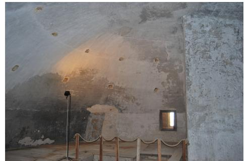
Fig. 8. Interno del torrione: volta a cupola del livello superiore.
